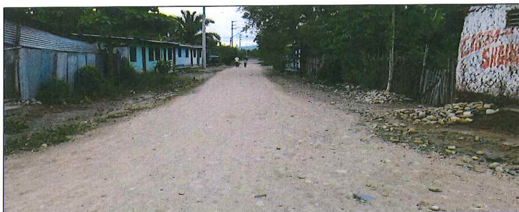
Jr. Bolognesi C-01, en el cual no existe sistema de drenaje pluvial, siendo necesario su ejecución, se proyecta cunetas y alcantarillas.
