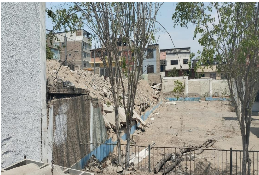
Imagen 06: Se aprecia material del cerco a remover para la conformación del muro de gravedad
