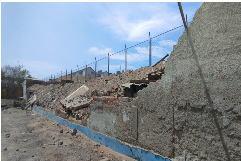
Imagen N°08: Se aprecia cerco de albañilería colapsado
