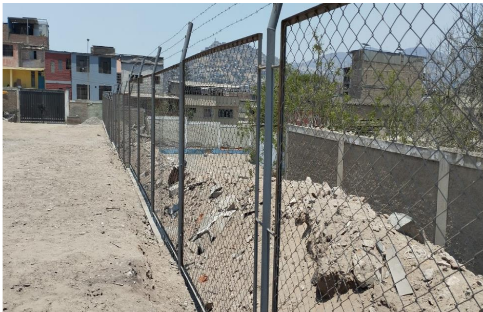
Imagen N°11: Se aprecia zona de cerco medianero inestable a ser removido.
