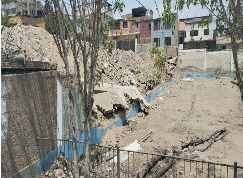
Imagen N°09: Se aprecia tramo del muro colapsado vista desde la I.E. 516
