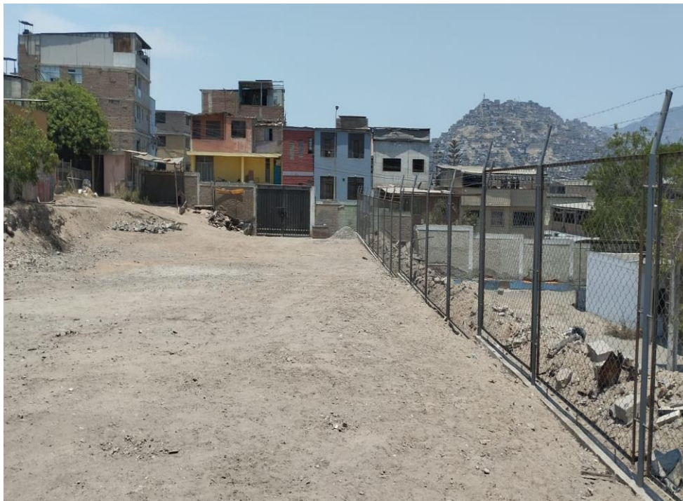
Imagen N°10: Se aprecia zona de cochera de la I.E. Medalla Milagrosa afectada por colapso de cerco con cerco temporal de malla olímpica.
