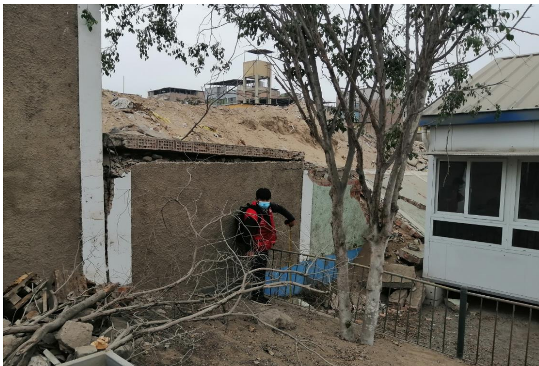
Imagen 09: Se aprecia cerco en mal estado a remover y diferencia de nivel en terreno de la I.E. 516
