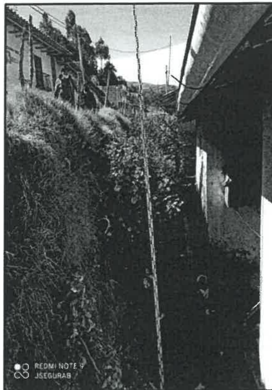
Imagen N° 28: Jr. Amazonas Cdra 8. La Encañada: Debido al desnivel existente se implementará un muro de contención.
