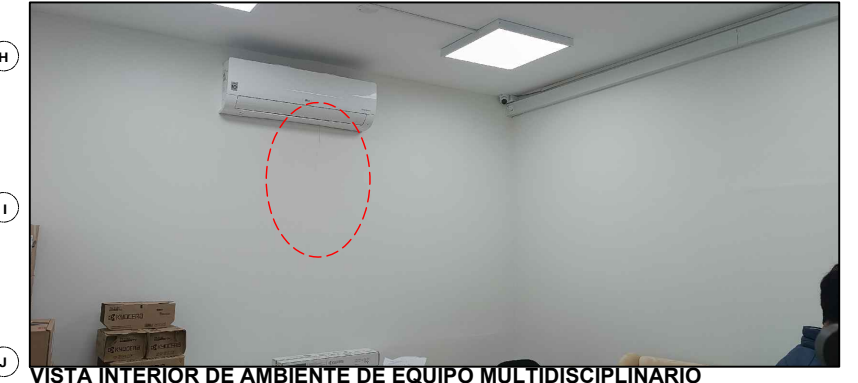
VISTA INTERIOR DE AMBIENTE DE EQUIPO MULTIDISCIPLINARIO REQUIERE RESANE DE FISURAS EN LOS MUROS, PINTADO DE MUROS Y CIELORRASO DEL MISMO COLOR EXISTENTE.
