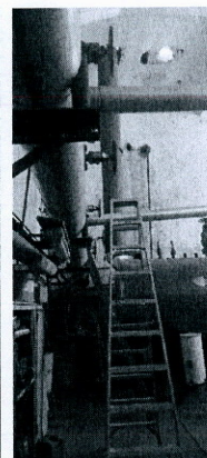
Foto N° 12: Se observa que la línea de distribución de agua blanda que alimenta el caldero presenta corrosión.
