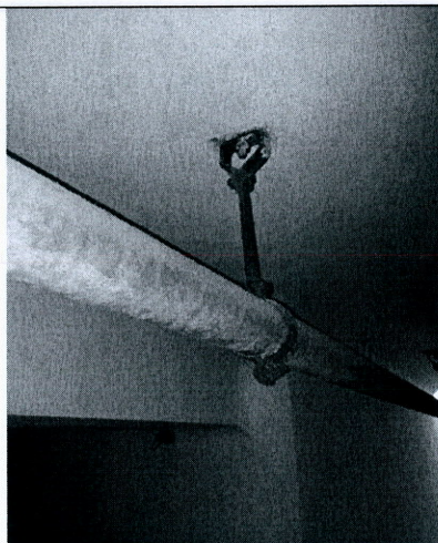
Foto N° 3: Sótano: Se observa la oxidación de los ganchos que empotran las tuberías de hierro.
