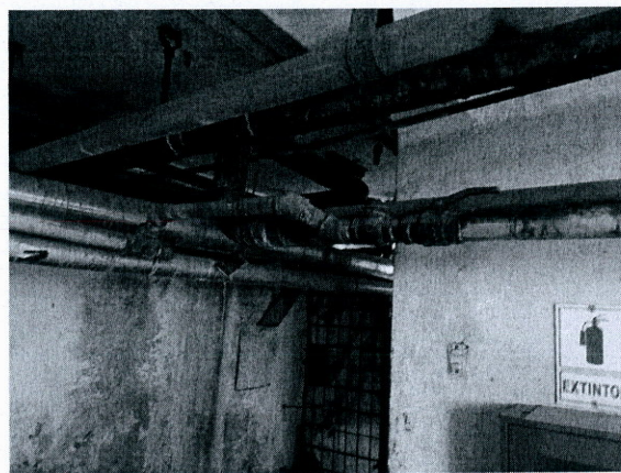
Foto N° 04 : Sótano: Se observa la oxidación en las tuberías que se encuentran empotradas al techo.
