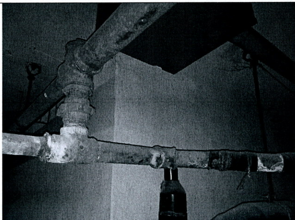
Foto N°05: Sótano: Se observa la corrosión de las tuberías de agua sótano.
