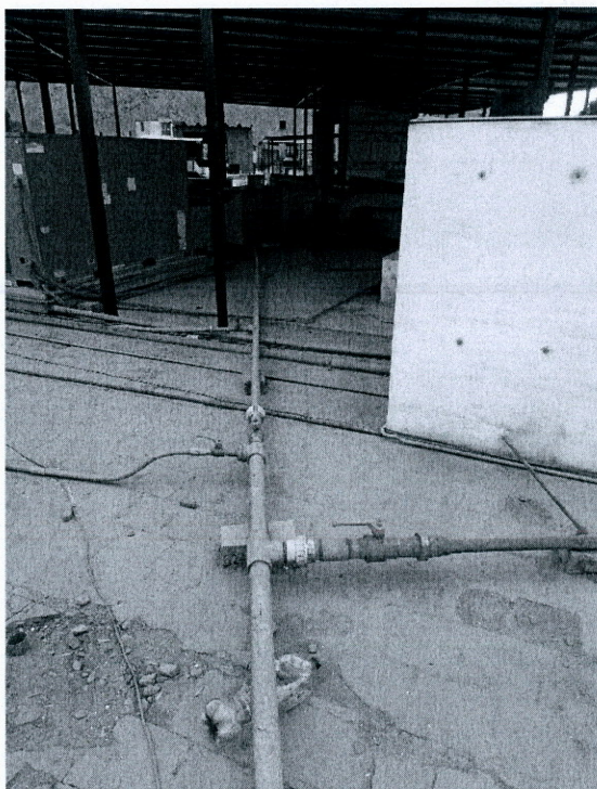
Foto N°07: Azotea: Se observa la corrosión de las válvulas de sectorización y tubería de PVC no cuenta con soportería y no tiene un orden de instalación.
