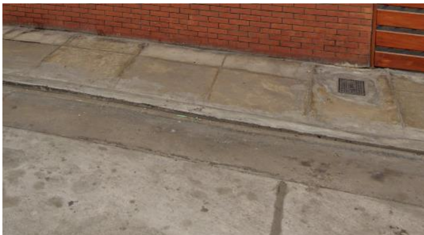
Grietas y desprendimiento del concreto en veredas
