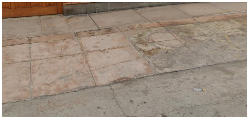
Grietas y desprendimiento del concreto en veredas
