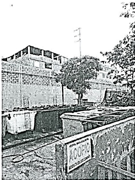
IMAGEN 05: CONTENEDORES EXPUESTOS SIN COBERTURA NI MUROS PERIMETRICOS
