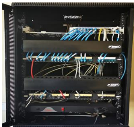
Figura 06: Instalación de bandeja de fibra en gabinete de borde.
