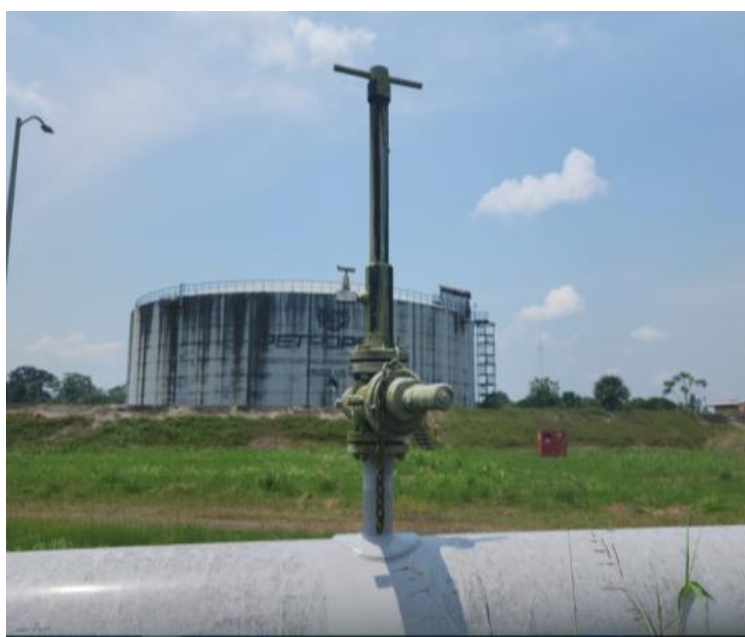
Fig. 7 Punto de reinyección de crudo.
