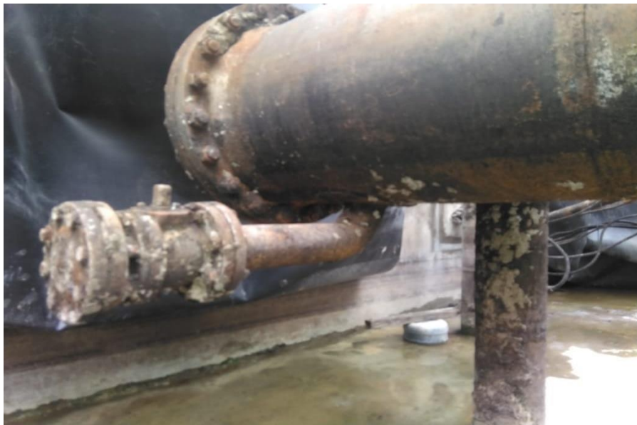
Fig. 1 Punto existente de con salida bridada Ø4"
