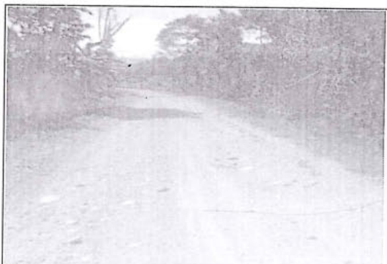
Foto 221: El tramo evaluado desde la prog. 23+255 a la prog. 23+500, presenta daños en la calzada de tipo Deformacion de nivel de gravedad: 3 alcanzando 4.60 m. de ancho de deterioro.
