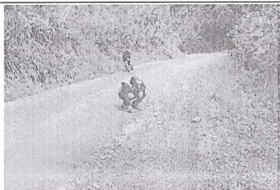
Foto 166: El tramo evaluado desde la prog. 07+000a la prog. 07+480, presenta daños en la calzada de tipo Erosión, de nivel de gravedad: 2 alcanzando 4.5 m. de ancho de deterioro.
