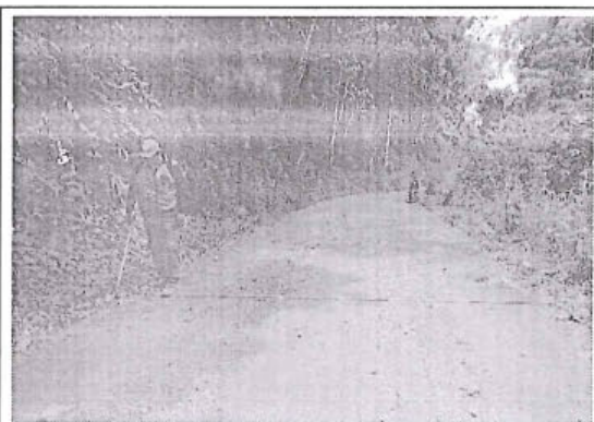
Foto 82: Superficie de rodadura en la prog. 12+500, superficie de tipo afirmado en buenas condiciones y buen estado de transitabilidad
