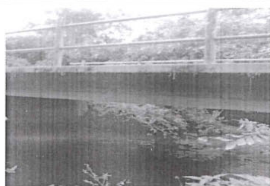
Foto 140: Pontón Definitivo de Tipo 2, con Tablero de rodadura de Concreto en Buena Condición Funcional, Prog. 21+260
