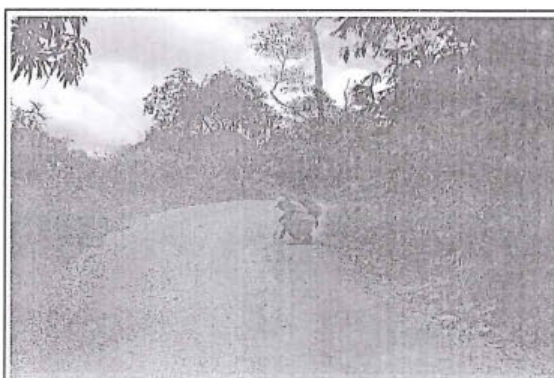
Foto 179: El tramo evaluado desde la prog. 12+630 a la prog. 13+000, presenta daños en la calzada de tipo Erosión , de nivel de gravedad: 3 alcanzando 4.00 m. de ancho de deterioro.
