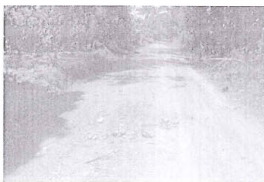
Foto 215: El tramo evaluado desde la prog. 22+480 a la prog. 22+516, presenta daños en la calzada de tipo Baches encontrándose 26, de nivel de gravedad: 2.
