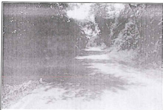
Foto 218: El tramo evaluado desde la prog. 22+720 a la prog. 22+750, presenta daños en la calzada de tipo Baches encontrándose 23, de nivel de gravedad: 2.
