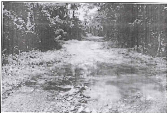
Foto 216: El tramo evaluado desde la prog. 22+590 a la prog. 22+600, presenta daños en la calzada de tipo Cruce de Agua , afectando todo el ancho de la vía (4.40 m.)
