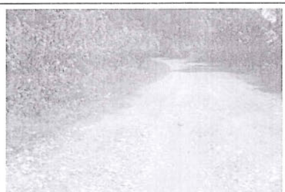
Foto 208: El tramo evaluado desde la prog. 20+710 a la prog. 20+754, presenta daños en la calzada de tipo Baches , encontrándose 24, de nivel de gravedad: 2.
