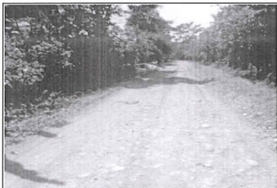
Foto 210: El tramo evaluado desde la prog. 21+320 a la prog. 21+480, presenta daños en la calzada de tipo Deformacion de nivel de gravedad: 3 alcanzando 4.40 m. de ancho de deterioro.
