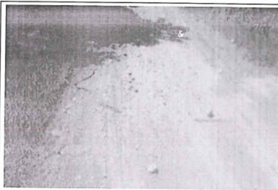
Foto 219: El tramo evaluado desde la prog. 22+970 a la prog. 22+990, presenta daños en la calzada de tipo Deformacion , de nivel de gravedad: 3 alcanzando 4.50 m. de ancho de deterioro.
