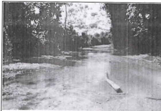
Foto 217: El tramo evaluado desde la prog. 22+660 a la prog. 22+710, presenta daños en la calzada de tipo Cruce de Agua , afectando todo el ancho de la vía (5.00 m.)
