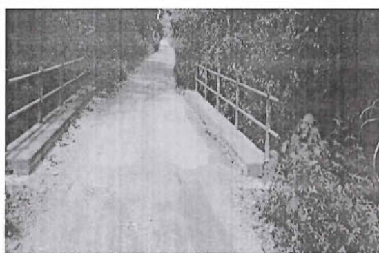
Foto 139: Pontón Definitivo de Tipo 2, con Tablero de rodadura de Concreto en Buena Condición Funcional, Prog. 21+260
