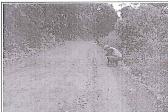
Foto 158: El tramo evaluado desde la prog. 04+831 a la prog. 04+940, presenta daños en la calzada de tipo Erosión , de nivel de gravedad: 3, alcanzando 3.00 m. de ancho de deterioro.
