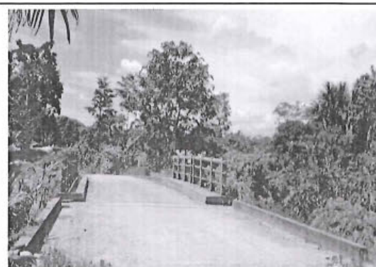
Foto 134: Pontón Definitivo de Tipo 2, con Tablero de rodadura de Concreto en Buena Condición Funciona, Prog. 20+600
