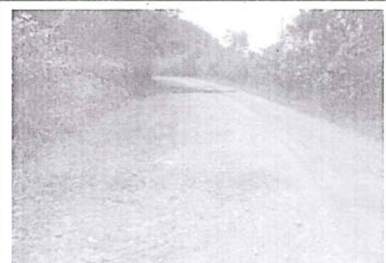
Foto 203: El tramo evaluado desde la prog. 20+040 a la prog. 20+083, presenta daños en la calzada de tipo Baches encontrándose 19, de nivel de gravedad: 1.
