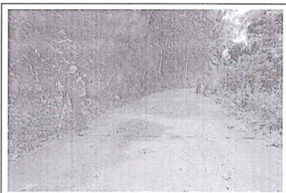
Foto 185: El tramo evaluado desde la prog. 15+000 a la prog. 15+500, presenta daños en la calzada de tipo Erosión, de nivel de gravedad: 2 alcanzando 4.50 m. de ancho de deterioro.
