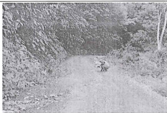
Foto 162: El tramo evaluado desde la prog. 05+700 a la prog. 06+000, presenta daños en la calzada de tipo Erosión, de nivel de gravedad: 2, alcanzando 4 m. de ancho de deterioro.
