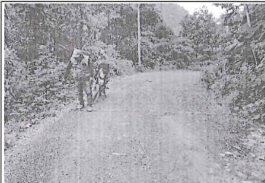
Foto 50: Superficie de rodadura en la prog. 06+500, presenta daños en la calzada de tipo Erosión.
