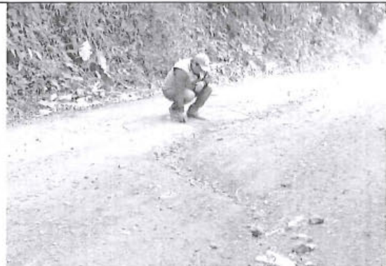
Foto 163: El tramo evaluado desde la prog. 06+140 a la prog. 06+500, presenta daños en la calzada de tipo Erosión, de nivel de gravedad: 2, alcanzando 3.6 m. de ancho de deterioro.
