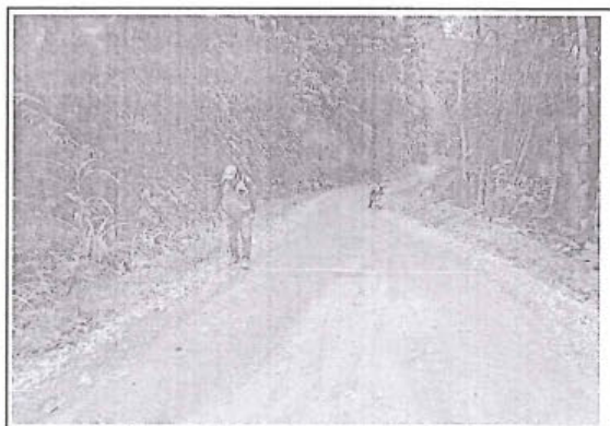
Foto 78: Superficie de rodadura en la prog. 12+000, cuenta con superficie de rodadura de tipo Afirmado en buenas condiciones y buen estado de transitabilidad.
