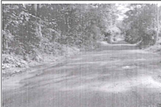
Foto 157: El tramo evaluado desde la prog. 04+680 a la prog. 04+706, presenta daños en la calzada de tipo Baches , encontrándose 19, de nivel de gravedad: 1.
