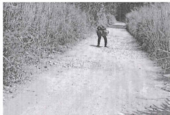
Foto 199: El tramo evaluado desde la prog. 18+800 a la prog. 18+839, presenta daños en la calzada de tipo Baches, encontrándose 26, de nivel de gravedad: 3.
