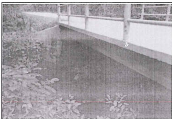
Foto 141: Pontón Definitivo de Tipo 2, con Tablero de rodadura de Concreto en Buena Condición Funcional, Prog. 21+260
