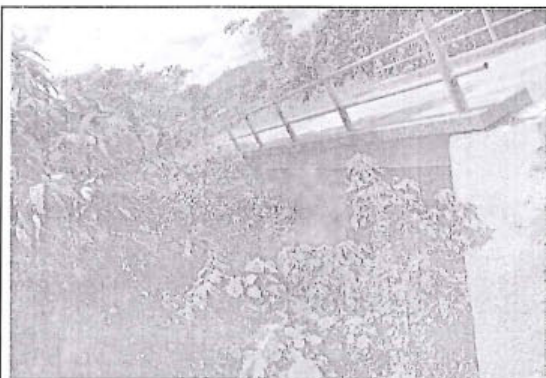
Foto 113: Pontón Definitivo de Tipo 2, con Tablero de rodadura de Concreto en Buena Condición Funcional, Prog. 16+850
