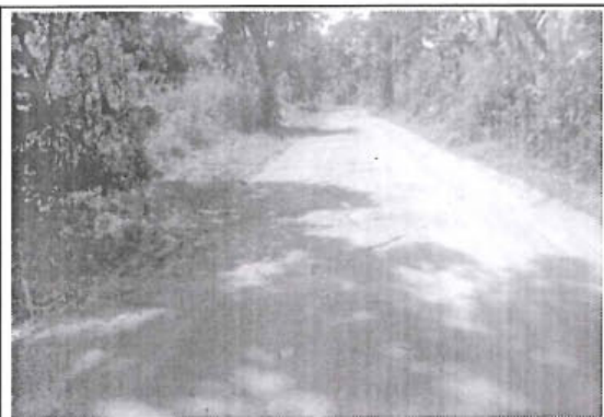
Foto 222: El tramo evaluado desde la prog. 23+510 a la prog. 23+521, presenta daños en la calzada de tipo Baches encontrándose 20, de nivel de gravedad: 2.
