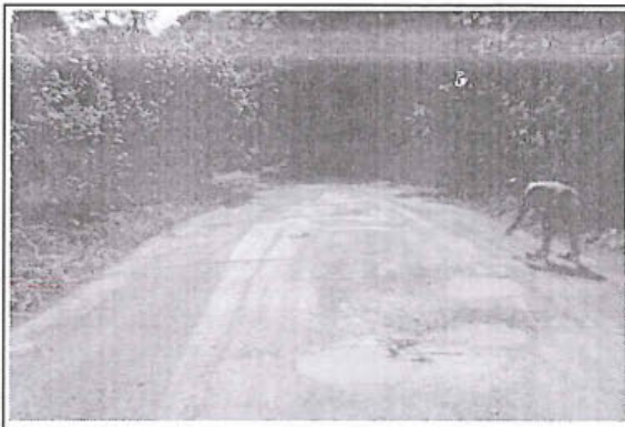
Foto 171: El tramo evaluado desde la prog. 09+500 a la prog. 09+541 , presenta daños en la calzada de tipo Baches encontrándose 23, de nivel de gravedad: 2.
