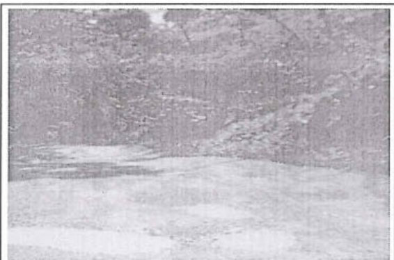
Foto 172: El tramo evaluado desde la prog. 09+800 a la prog. 09+880 , presenta daños en la calzada de tipo Baches encontrándose 25, de nivel de gravedad: 2.
