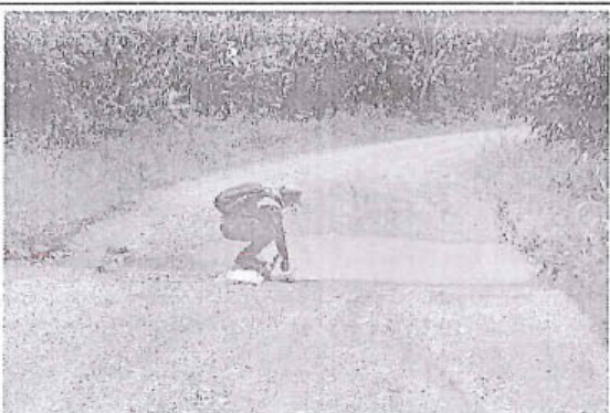
Foto 188: El tramo evaluado desde la prog. 16+550 a la prog. 16+612, presenta daños en la calzada de tipo Baches encontrándose 22, de nivel de gravedad: 2.
