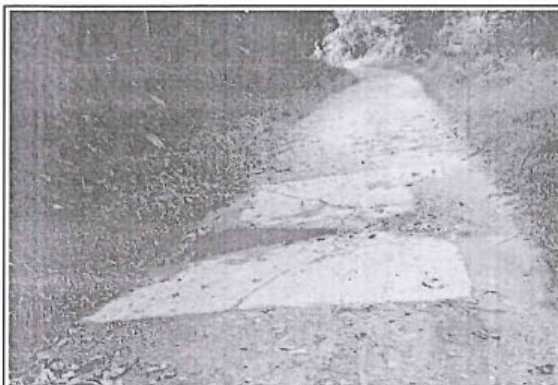
Foto 67: Badén en regulares condiciones, presenta daños como agrietamientos de la losa de la estructura. Prog. 09+810
