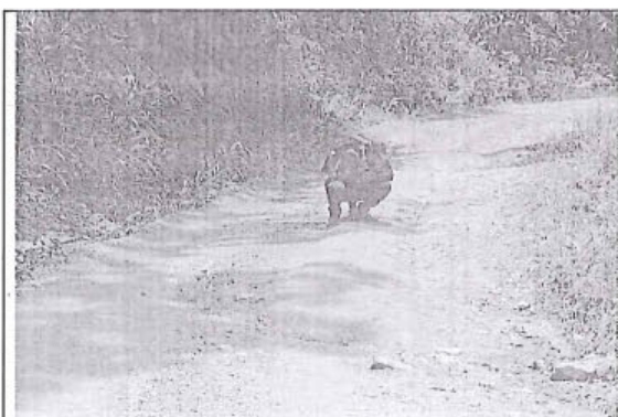
Foto 178: El tramo evaluado desde la prog. 12+150a la prog. 12+500, presenta daños en la calzada de tipo Erosión , de nivel de gravedad: 2 alcanzando 4.0 m. de ancho de deterioro.
