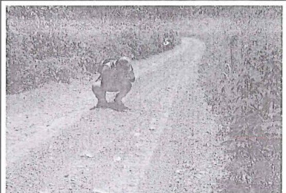
Foto 195: El tramo evaluado desde la prog. 17+940 a la prog. 18+000, presenta daños en la calzada de tipo Erosión, de nivel de gravedad: 3 alcanzando 4.6 m. de ancho de deterioro.
