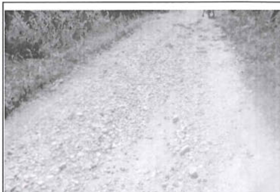
Foto 223: El tramo evaluado desde la prog. 23+540 a la prog. 23+550, presenta daños en la calzada de tipo Erosión , de nivel de gravedad: 3 alcanzando 4.50 m. de ancho de deterioro.
