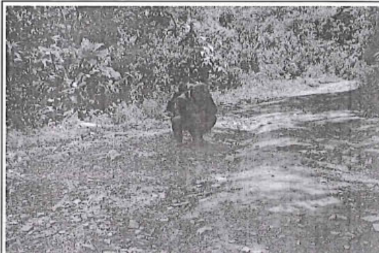
Foto 187: El tramo evaluado desde la prog. 16+315 a la prog. 16+500, presenta daños en la calzada de tipo Erosión , de nivel de gravedad: 3 alcanzando 4.40 m. de ancho de deterioro.
