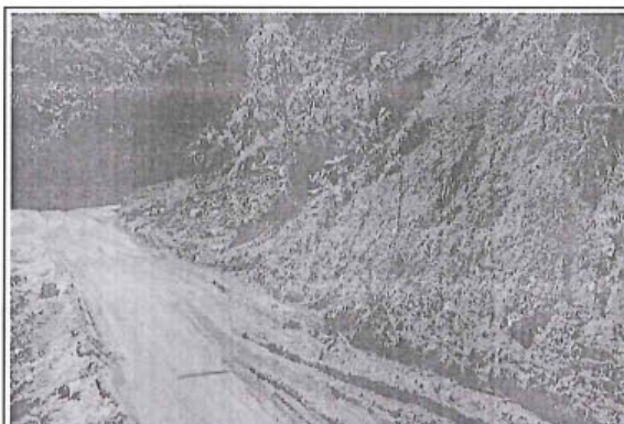
Foto 168: El tramo evaluado desde la prog. 08+000a la prog. 08+440, presenta daños en la calzada de tipo Erosión , de nivel de gravedad: 3 alcanzando 4 m. de ancho de deterioro.
