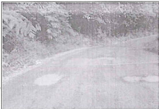
Foto 164: El tramo evaluado desde la prog. 06+550 a la prog. 06+590, presenta daños en la calzada de tipo Baches, encontrándose 20, de nivel de gravedad: 1.
