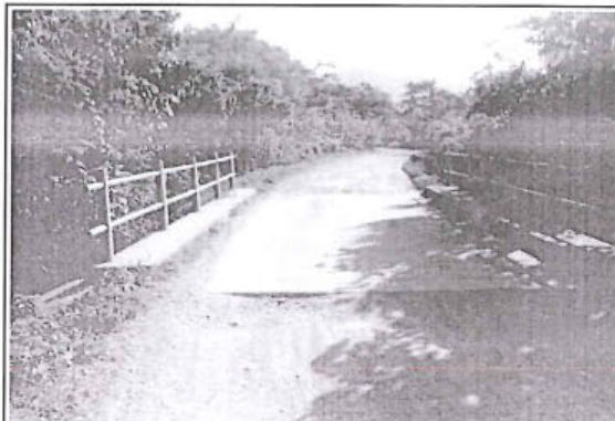
Foto 112: Pontón Definitivo de Tipo 2, con Tablero de rodadura de Concreto en Buena Condición Funcional, Prog. 16+850
