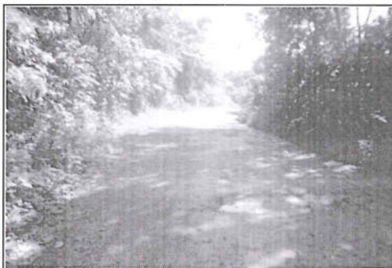
Foto 169: El tramo evaluado desde la prog. 08+500 a la prog. 08+567 , presenta daños en la calzada de tipo Baches encontrándose 21, de nivel de gravedad: 1.
