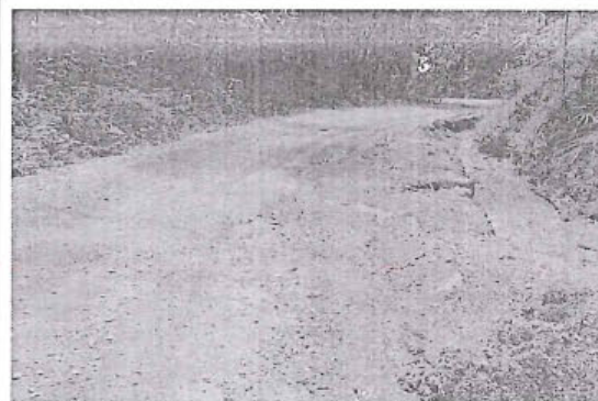
Foto 177: El tramo evaluado desde la prog. 11+500a la prog. 11+970, presenta daños en la calzada de tipo Erosión , de nivel de gravedad: 3 alcanzando 4.00 m. de ancho de deterioro.
