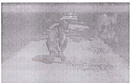
Foto 201: El tramo evaluado desde la prog. 19+150 a la prog. 19+195, presenta daños en la calzada de tipo Baches encontrándose 20, de nivel de gravedad: 1.
