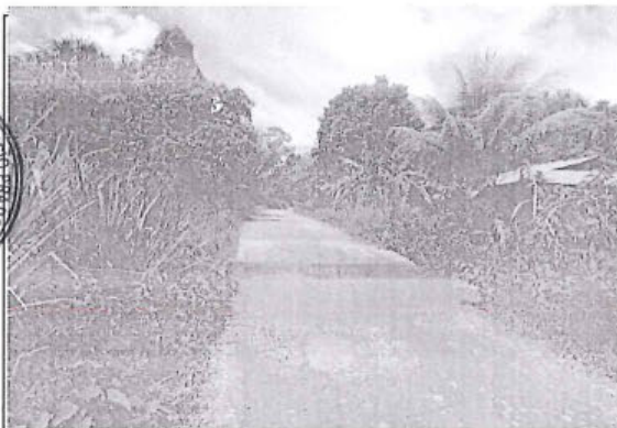
Foto 194: El tramo evaluado desde la prog. 17+690 a la prog. 17+720, presenta daños en la calzada de tipo Baches encontrándose 23, de nivel de gravedad: 2.
