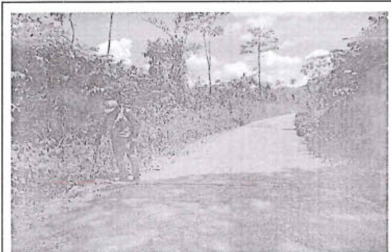
Foto 200: El tramo evaluado desde la prog. 18+820 a la prog. 19+000, presenta daños en la calzada de tipo Erosión, de nivel de gravedad: 3 alcanzando 4.60 m. de ancho de deterioro.
