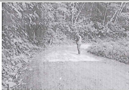
Foto 49: Badén en mala condición funcional y pésimo estado de conservación, se observan las losas erosionadas y colapsadas Prog. 06+410.
