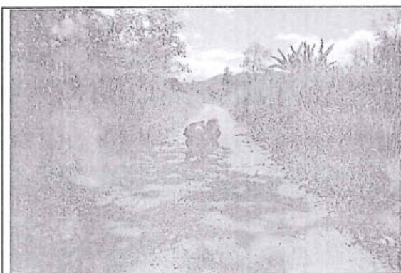
Foto 202: El tramo evaluado desde la prog. 19+500 a la prog. 20+000, presenta daños en la calzada de tipo Erosión, de nivel de gravedad: 1 alcanzando 4.70 m. de ancho de deterioro.
