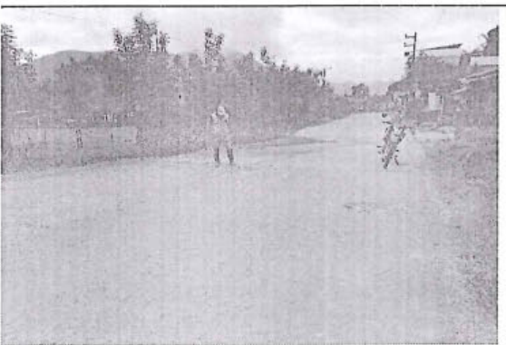
Foto 35: inicio del tramo de la superficie de rodadura en la prog. 04+567, de tipo Afirmando en buenas condiciones y buen estado de transitabilidad.
