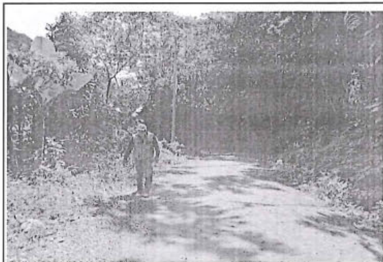
Foto 55: Superficie de rodadura en la prog. 07+50, cuenta con superficie de rodadura de tipo Afirmado en buenas condiciones y buen estado de transitabilidad.
