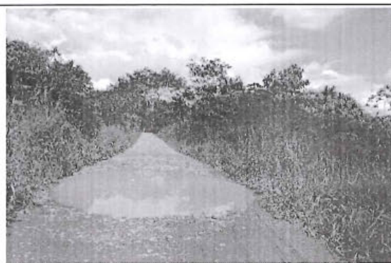
Foto 204: El tramo evaluado desde la prog. 20+177 a la prog. 20+190, presenta daños en la calzada de tipo Cruce de Agua , afectando todo el ancho de la vía (4.50 m.)
