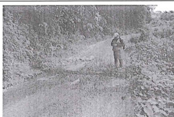
Foto 156: El tramo evaluado desde la prog. 04+580 a la prog. 04+640, presenta daños en la calzada de tipo Baches , encontrándose 20, de nivel de gravedad: 1.
