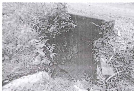
Foto 80: Alcantarilla de concreto, en buena condicional funcional y buen estado de conservación. Prog. 12+380 .
