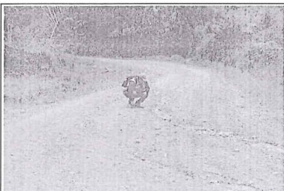
Foto 184: El tramo evaluado desde la prog. 14+945 a la prog. 15+120, presenta daños en la calzada de tipo Erosión, de nivel de gravedad: 3 alcanzando 5.00 m. de ancho de deterioro.
