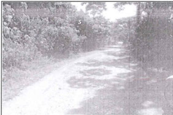
Foto 213: El tramo evaluado desde la prog. 22+160 a la prog. 22+170, presenta daños en la calzada de tipo Deformacion de nivel de gravedad: 3 alcanzando 4.50 m. de ancho de deterioro.
