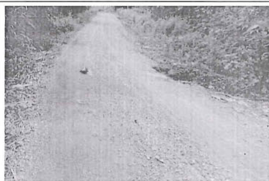
Foto 180: El tramo evaluado desde la prog. 13+000a la prog. 13+500, presenta daños en la calzada de tipo Erosión, de nivel de gravedad: 3 alcanzando 4.00 m. de ancho de deterioro.
