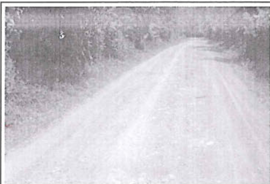
Foto 212: El tramo evaluado desde la prog. 21+925 a la prog. 21+960 presenta daños en la calzada de tipo Baches encontrándose 19, de nivel de gravedad: 2.
