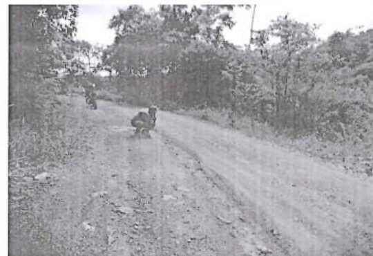
Foto 175: El tramo evaluado desde la prog. 10+515 a la prog. 11+000, presenta daños en la calzada de tipo Erosión , de nivel de gravedad: 3 alcanzando 4.10 m. de ancho de deterioro.
