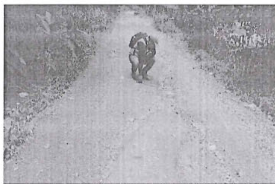
Foto 174: El tramo evaluado desde la prog. 10+020a la prog. 10+500, presenta daños en la calzada de tipo Erosión , de nivel de gravedad: 3 alcanzando 4.00 m. de ancho de deterioro.
