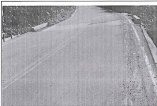
Foto 19: Superficie de rodadura en la prog. 03+500, cuenta con superficie de rodadura de tipo Asfaltado en buenas condiciones y buen estado de transitabilidad. No presenta algún tipo de daño en la calzada.
