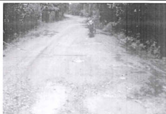
Foto 211: El tramo evaluado desde la prog. 21+670 a la prog. 21+684, presenta daños en la calzada de tipo Baches encontrándose 26, de nivel de gravedad: 2.
