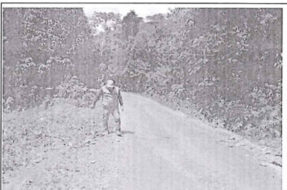
Foto 173: El tramo evaluado desde la prog. 09+820a la prog. 10+000, presenta daños en la calzada de tipo Erosión , de nivel de gravedad: 1 alcanzando 4.2 m. de ancho de deterioro.
