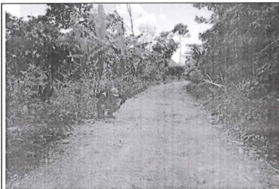
Foto 198: El tramo evaluado desde la prog. 18+548 a la prog. 18+800, presenta daños en la calzada de tipo Erosión, de nivel de gravedad: 3 alcanzando 4.80 m. de ancho de deterioro.
