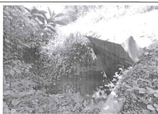
Foto 128: Alcantarilla de Concreto con tablero de rodadura de concreto, en buena condicion funcional y buen estado de conservacion. Prog. 19+080
