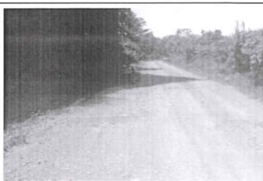
Foto 205: El tramo evaluado desde la prog. 20+245 a la prog. 20+296, presenta daños en la calzada de tipo Baches , encontrándose 23, de nivel de gravedad: 2.
