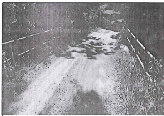
Foto 74: Pontón Definitivo de Tipo 2, con Tablero de rodadura de Concreto en Buena Condición Funcional, Prog. 11+110
