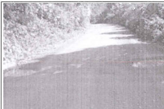
Foto 159: El tramo evaluado desde la prog. 04+940 a la prog. 04+990, presenta daños en la calzada de tipo Baches , encontrándose 15, los cuales son de nivel de gravedad: 1.
