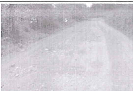
Foto 207: El tramo evaluado desde la prog. 20+470 a la prog. 20+500, presenta daños en la calzada de tipo Baches , encontrándose 23, de nivel de gravedad: 2.
