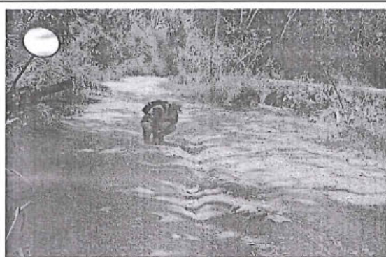
Foto 186: El tramo evaluado desde la prog. 15+510 a la prog. 15+575, presenta daños en la calzada de tipo Deformacion de nivel de gravedad: 3 alcanzando 4.30 m. de ancho de deterioro.
