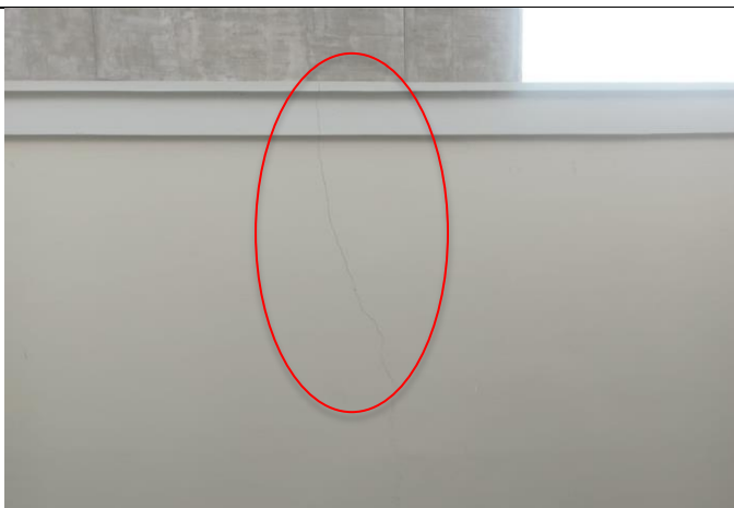
Foto 5. Rajadura en el muro del patio interior del Edificio Víctor Raúl Haya de la Torre
