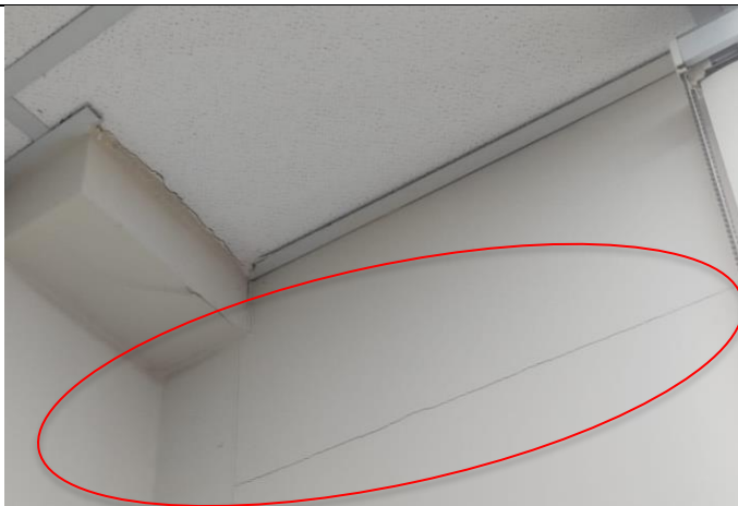
Foto 3. Rajadura en la pared de la oficina de la Comisión de Educación, Juventud y Deporte (Drywall) del Edificio Víctor Raúl Haya de la Torre
