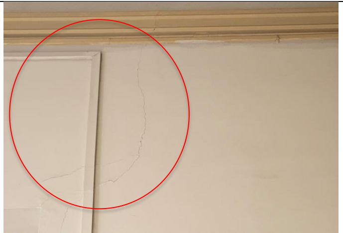
Foto 2. Rajadura en el muro sobre la puerta de las oficinas de Renovación Popular en Palacio Legislativo
