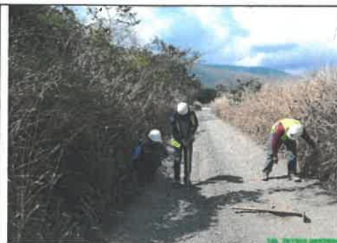
FOTO N° 19: Cunetas colmatadas, prog. 41+750
