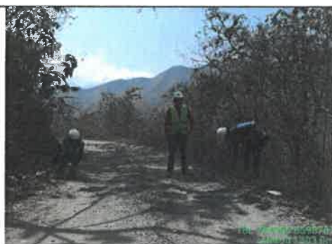
FOTO N° 14: Cunetas colmatadas, prog. 31+500
