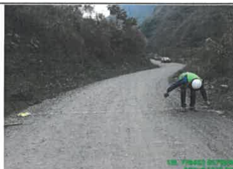
FOTO N° 02: Cunetas colmatadas, prog. 05+000
