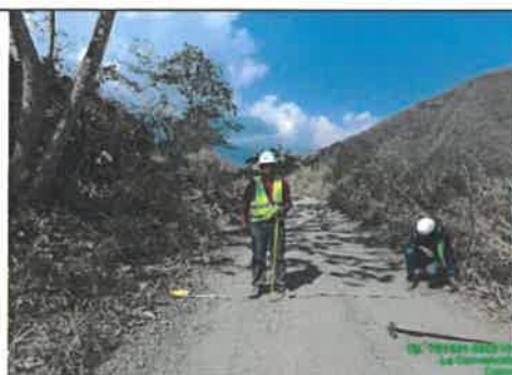
FOTO N° 20: Cunetas colmatadas, prog. 42+250
