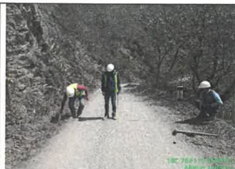
FOTO N° 13: Cunetas colmatadas, prog. 31+250
