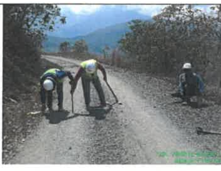
FOTO N° 16: Cunetas colmatadas, prog. 33+750
