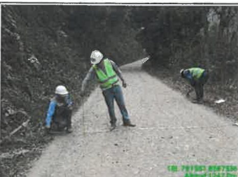
FOTO N° 05: Cunetas colmatadas, prog. 13+500
