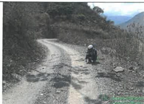
FOTO N° 15: Cunetas colmatadas, prog. 33+000
