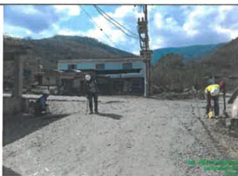
FOTO N° 22: Ausencia de cunetas, prog. 42+751
