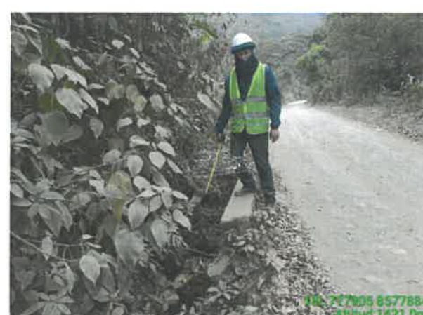
Foto N° 447 DESCRIPCION: MAL ESTADO ALCANTARILLA PROGRESIVA 2+505 Existente
