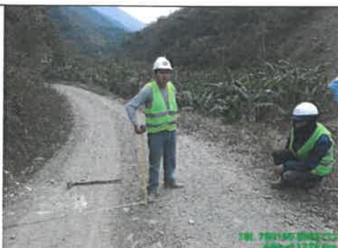
FOTO N° 03: Cunetas colmatadas, prog. 09+750
