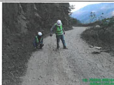
FOTO N° 08: Cunetas colmatadas, prog. 20+250
