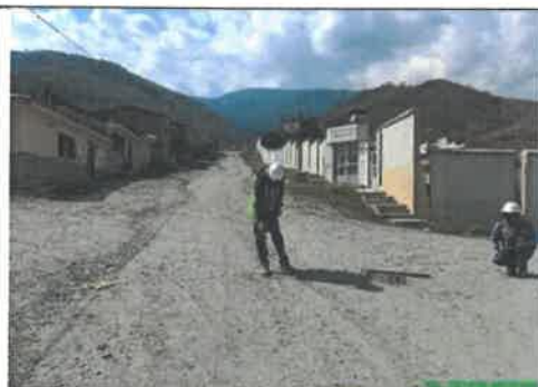
FOTO N° 21: Ausencia de cunetas, prog. 42+500
