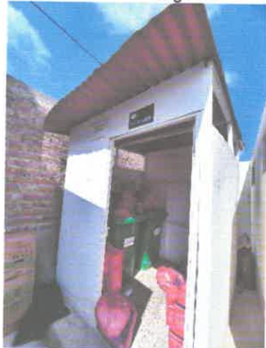
Módulo de almacenamiento de residuos biocontaminantes afectado por falta de mantenimiento-pintura, cerradura afectada oxidada malograda.
