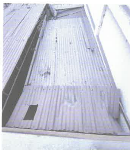
Cobertura planchas de calaminas fibraforte colapsadas – requieren sustitución por calaminas de larga duración ALUZIN 0.40mm
