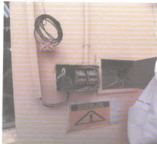
Accesorio interruptor de luz afectado- tablero eléctrico con deficiencias
