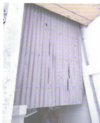
Cobertura planchas de calaminas fibraforte colapsadas – requieren sustitución por calaminas de larga duración ALUZIN 0.40mm
