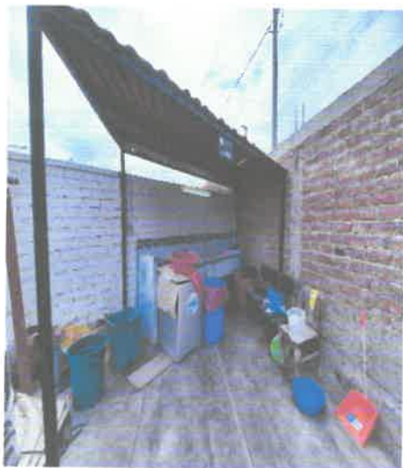
Módulo de almacenamiento de residuos biocontaminantes afectado por falta de mantenimiento-pintura, cerradura afectada oxidada malograda.
