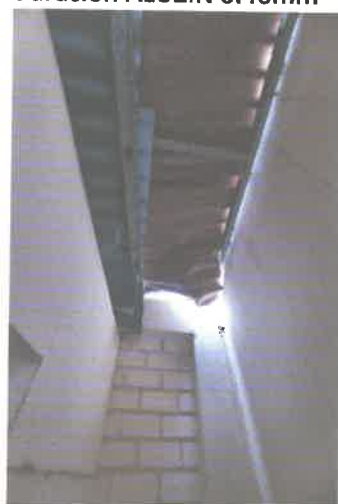
Cobertura planchas de calaminas fibraforte colapsadas – requieren sustitución por calaminas de larga duración ALUZIN 0.40mm
