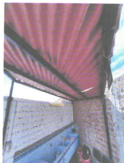
Módulo de almacenamiento de residuos biocontaminantes afectado por falta de mantenimiento-pintura, cerradura afectada oxidada malograda.
