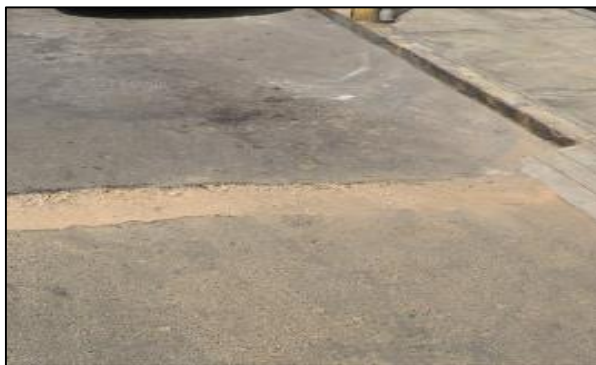
Rotura y reposición de pavimento
