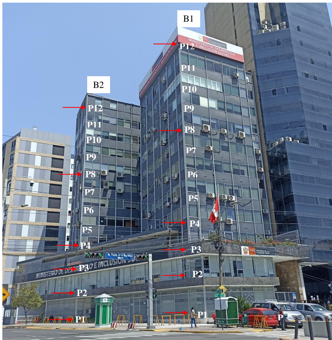
Figura 3.- Ubicación de sensores sísmicos en cada bloque (Arreglos verticales, vista de perfil del edificio)
