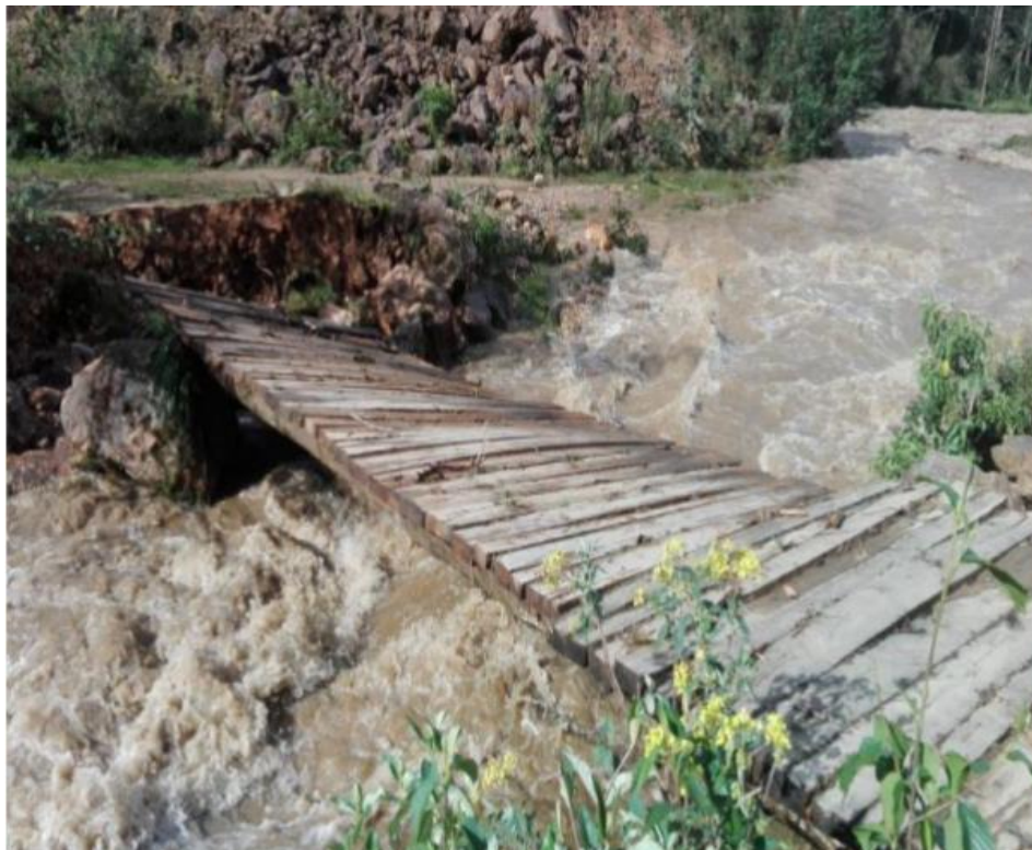
Imagen N°04 Estado Actual de Puente Colapsado.
