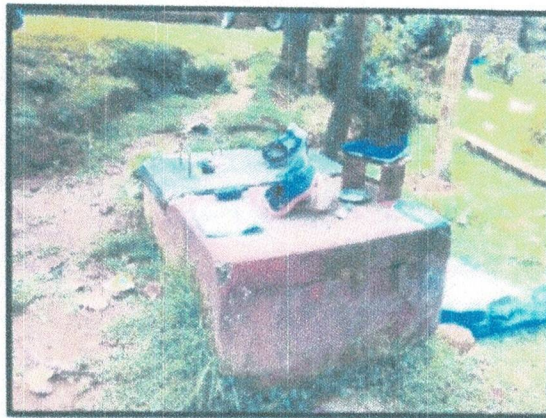
VISTA N° 3: Cámara rompe presión con fisuras.
