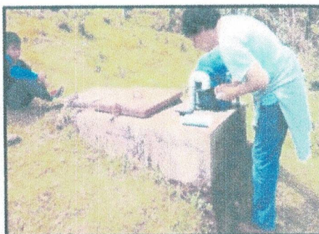
VISTA N° 6: Cámara rompe presión existente.
