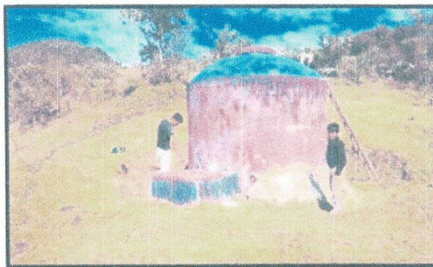
VISTA N° 4: Reservorio existente en mal estado a cambiar, presenta fisuras.
