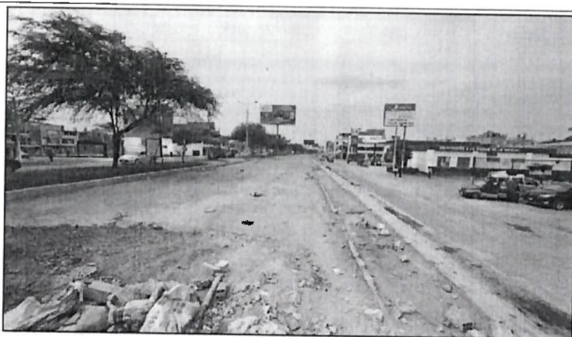
Estructura de Sardinel en mal estado.
