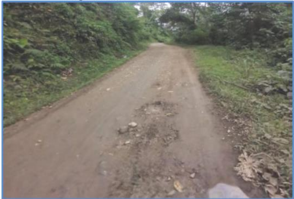
Fotografía N°02: Ondulaciones de la vía
