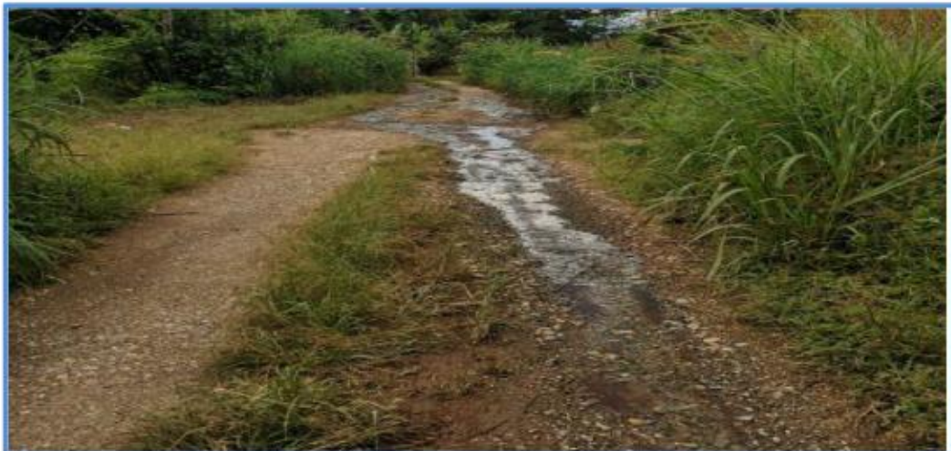
Fotografía N° 06: Cunetas coberturadas de malesas
