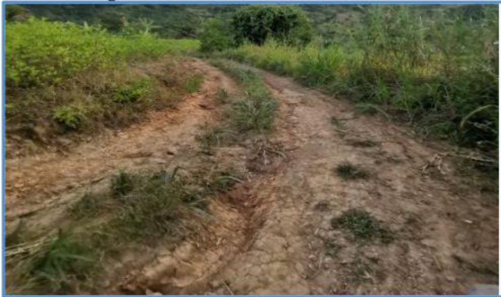
Fotografía N°03: Ahuellamiento de la vía
