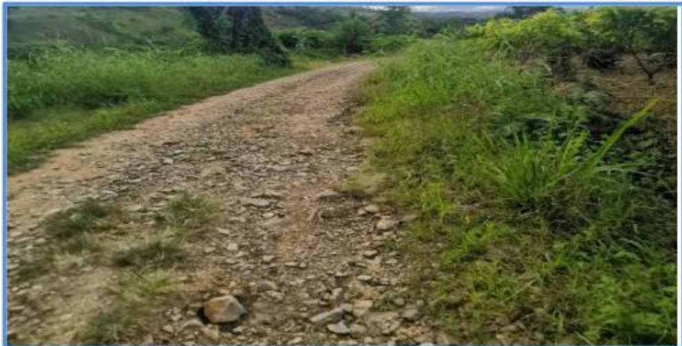
Fotografía N°05: Surcos de erosión en la vía
