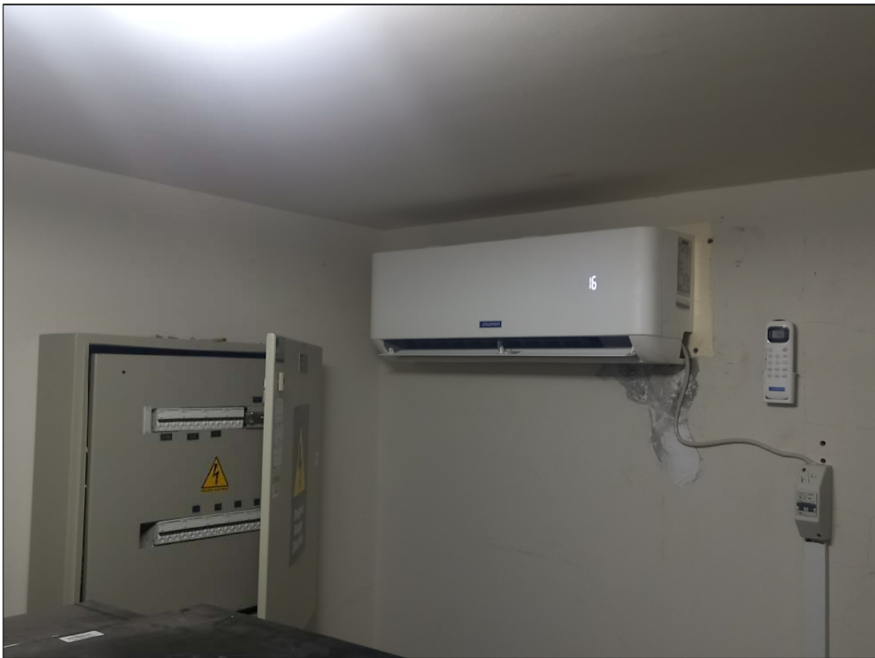
INSTALACION DE AIRE ACONDICIONADO PARA CUARTO DE TABLEROS
