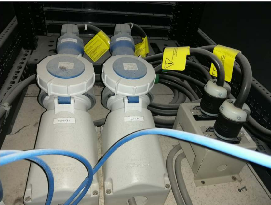
INSTALACION DE TOMAS INDUSTRIALES EN PISO TECNICO
