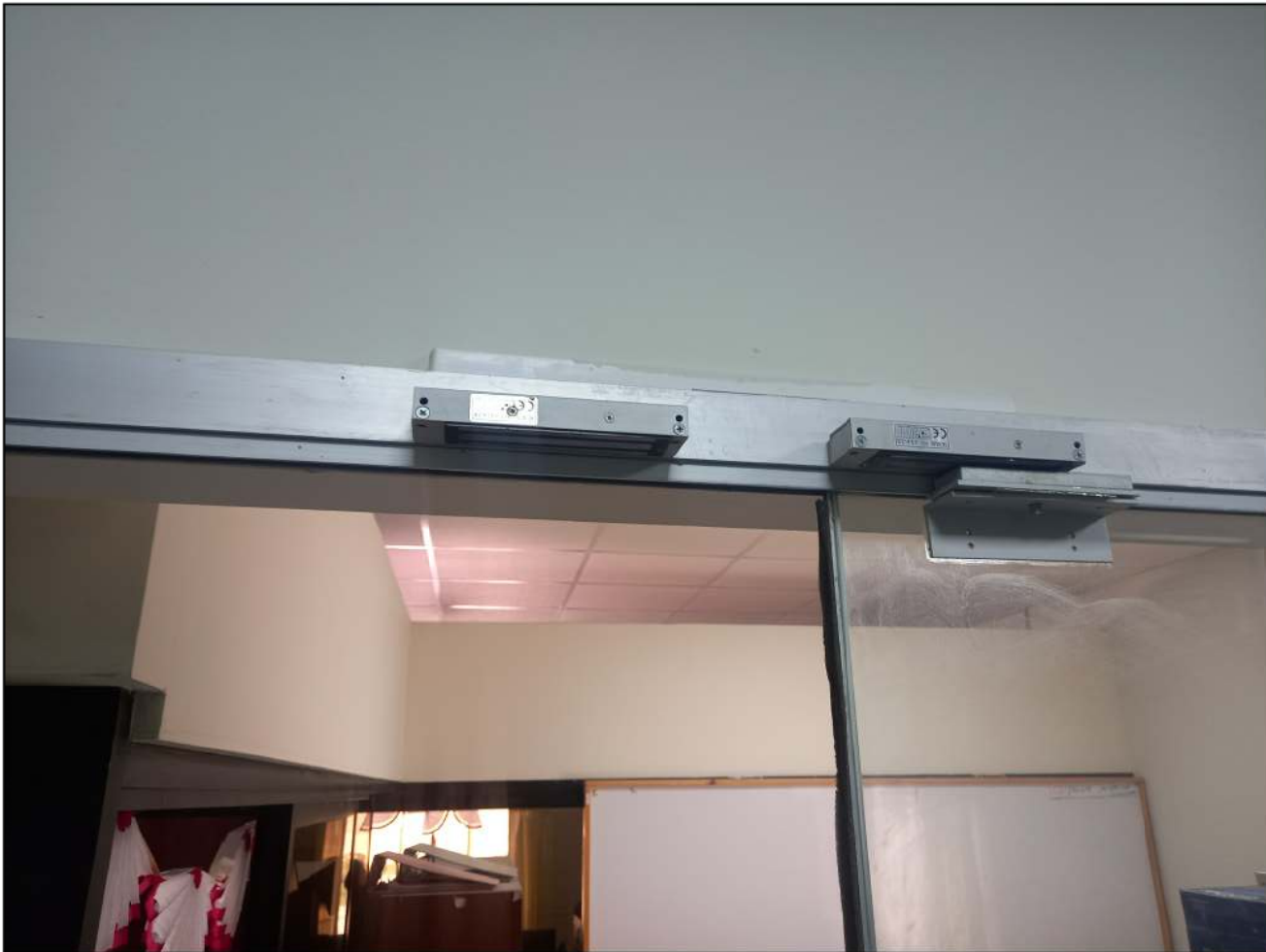
INSTALACION DE CERRADURA ELECTROMAGNETICO EN MALA CONDICION
