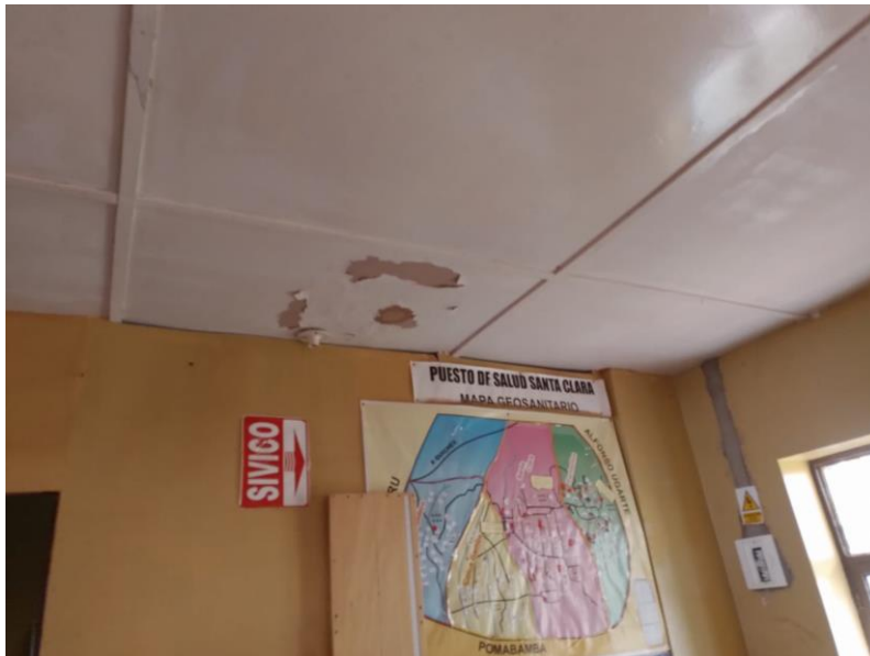
FOTO N°06: CIELO RASO DE FIBROCEMENTO EN MAL ESTADO
