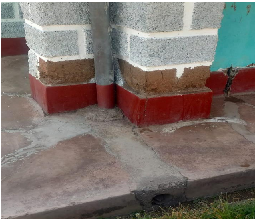
FOTO N°06: MONTANTES DETERIORADOS
