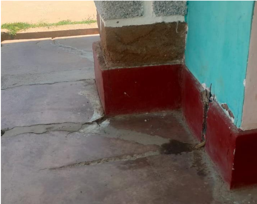
FOTO N°04: CIELORASO EN MAL ESTADO
