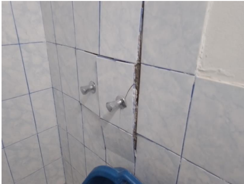
FOTO N°08: ACCESORIOS DE LAVADEROS MALOGRADOS
