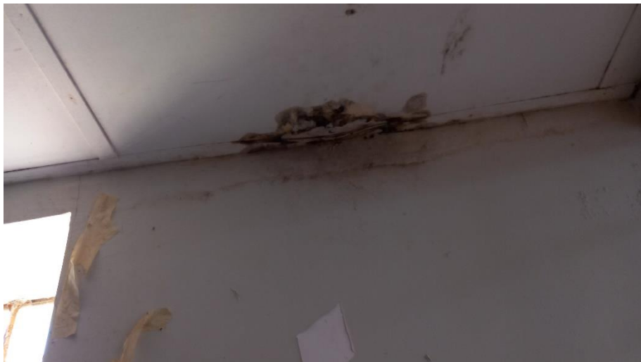
FOTO N°10: CIELO RASO DE FIBROCEMENTO EN MAL ESTADO
