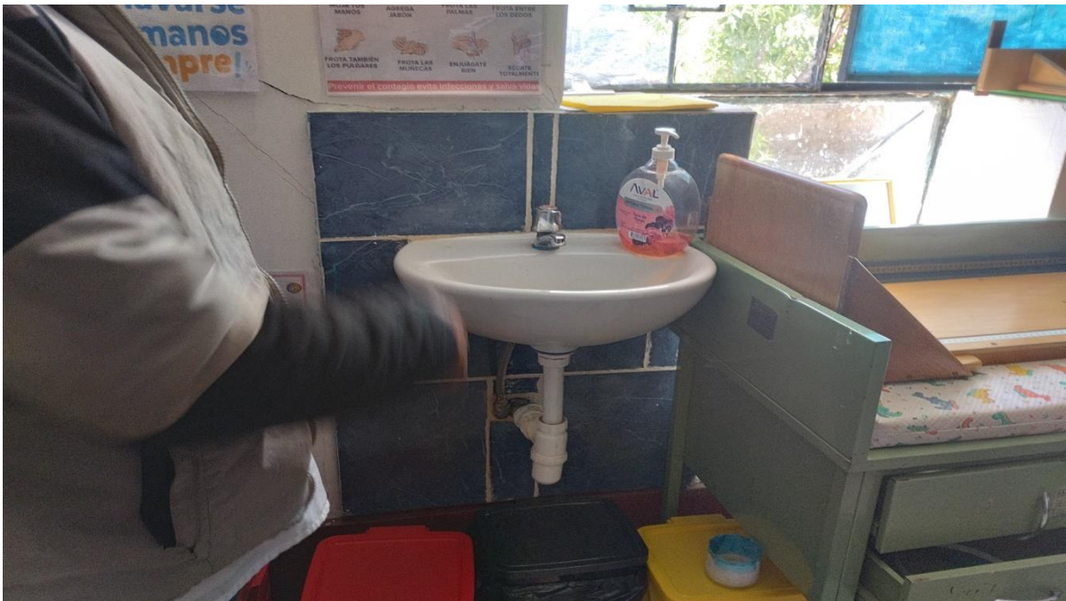
FOTO N°07; ACCESORIOS DE LAVADEROS MALOGRADOS
