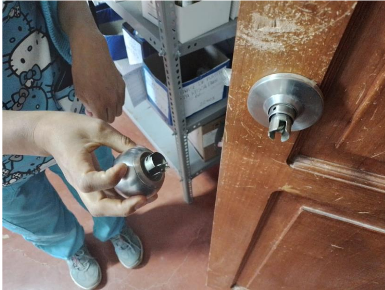
FOTO N°10: CHAPA DE LAS PUERTAS MALOGRADAS
