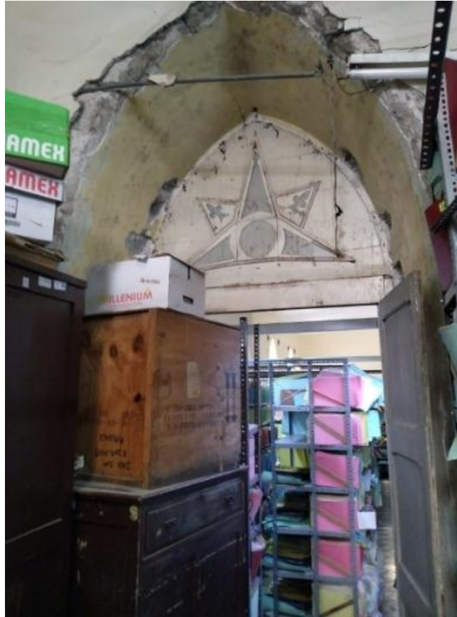
Retiro de tarrajeo deteriorado. Tarrajeo con impermeabilizante, pintado. Mantenimiento de puerta de madera patrimonial. Mejoramiento de la red eléctrica.
