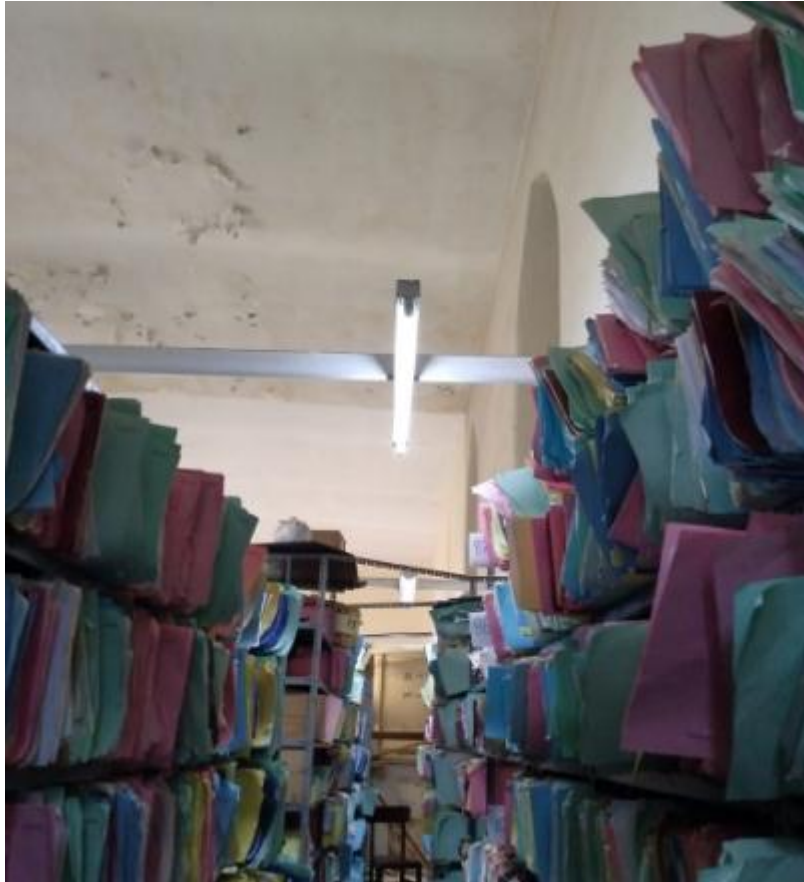
Ambiente de historias clínicas. Cielo raso con desprendimiento de pintura. Existencia de zonas loctas. Iluminación deficiente. Se necesita retiro de tarrajeo de zonas deterioradas. Tarrajeo con enmallado en muro contiguo a av. Goyeneche. Para mejor adherencia de Porcelanato y prevenir humedad y filtración.
