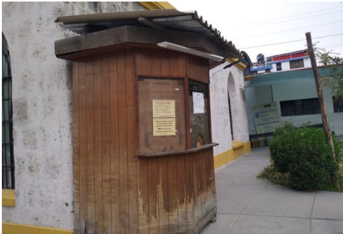
Mantenimiento de modulo patrimonial de madera. Cambio de cobertura, accesorios varios. Iluminación solar. Laminado de vidrio, lijado, barnizado. Y movilización a zona exterior de archivo de historias clínicas al finalizar el mantenimiento.
