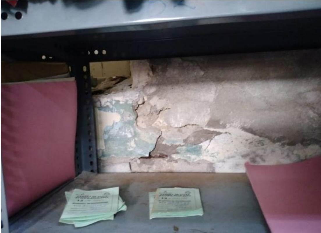
Deterioro de tarrajeo, presencia de humedad. Se propone retiro de tarrajeo, nuevo tarrajeo con malla, impermeabilizante y zócalo de Porcelanato a 2.40m.
