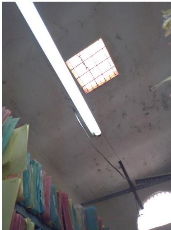
Lucernario en segundo ambiente de archivo de historias clínicas. Se evidencia humedad, por filtración de lluvias y desprendimiento de pintura. Se propone cobertura metálica en techo para protección ante lluvias. Retiro de tarrajeo deteriorado, tarrajeo con enmallado en muro colindante con la av. Goyeneche y pasaje santa rosa. Zócalo de Porcelanato 2.40m.
