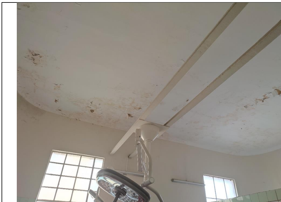
Estado actual de cielos rasos - Sala de Partos Desprendimiento de pintura y tarrajeo.
