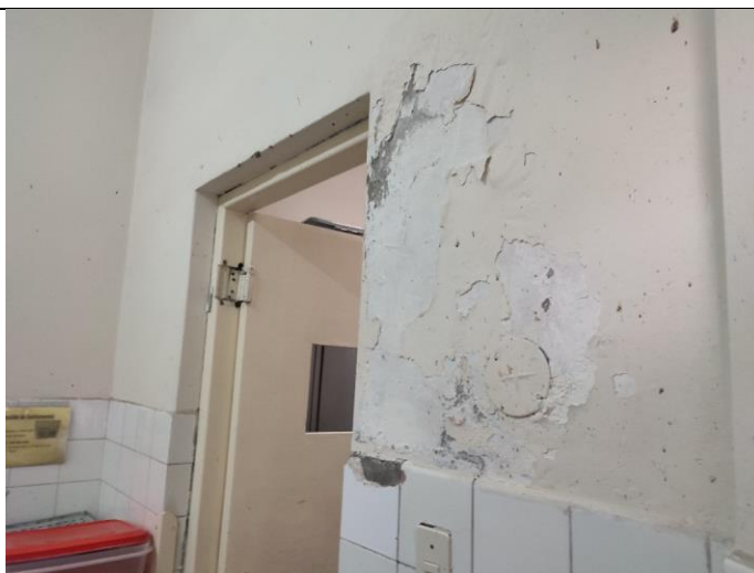
Estado actual de muros – Salas de Partos Desprendimiento de pintura y tarrajeo.
