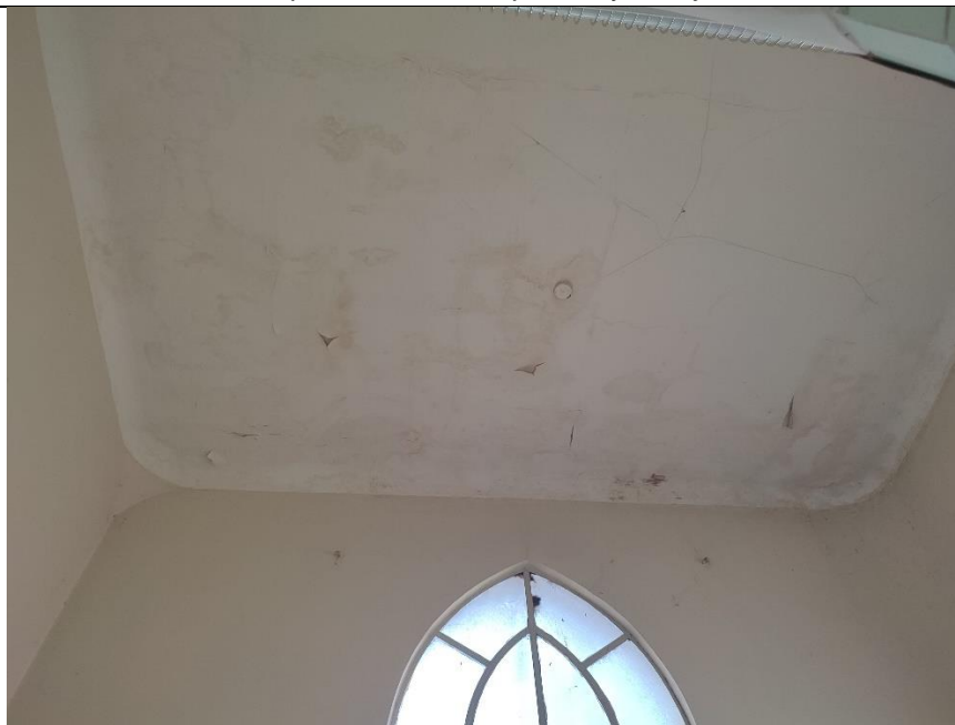
Estado actual de área de intervención – sala de atención inmediata del recién nacido Desprendimiento de pintura y tarrajeo.
