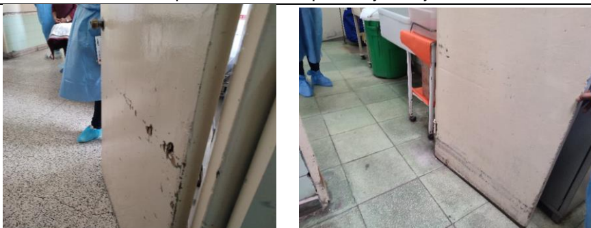
Estado actual de muros – Salas de Partos Desprendimiento de pintura y tarrajeo.
