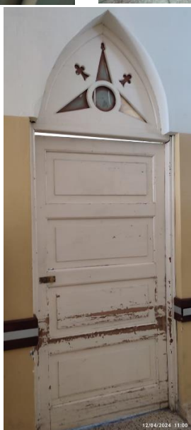
Estado actual de área de intervención – Ambientes complementarios de salas de parto Desprendimiento de pintura en puertas de madera y estado de pisos de ambientes.
