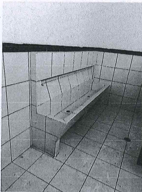
Fotografía 12. Demolición de urinario e instalación de urinarios individuales en el segundo y tercer nivel de los servicios higiénicos del Block "D".
