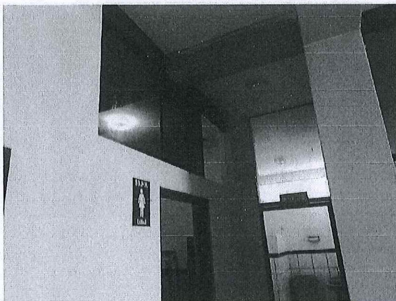
Fotografía 18. Laminado de vidrios en servicios higiénicos de mujeres y cambio de fresquilla de vidrio por muro de drywall en servicios higiénicos de varones en el tercer nivel del Block "D".
