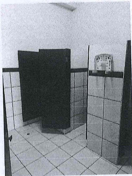
Fotografía 14. Demolición de muros divisorios de ladrillo e instalación de divisiones y puertas de melamina en el tercer nivel de los servicios higiénicos del Block "D".
