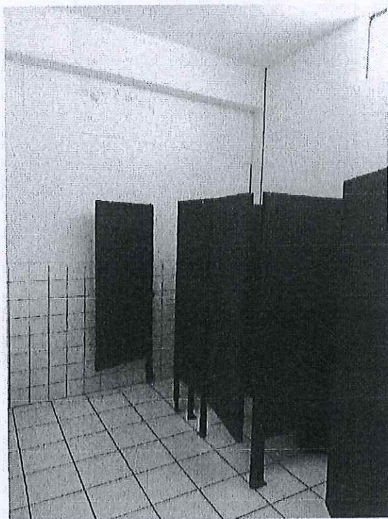
Fotografía 4. Cambio de separadores y puertas metálicas por melamina en los servicios higiénicos del primer nivel del Block "D".
