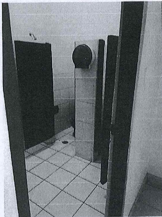
Fotografía 10. Demolición de muros divisorios de ladrillo e instalación de divisiones y puertas de melamina en los servicios higiénicos del segundo nivel del Block "D".
