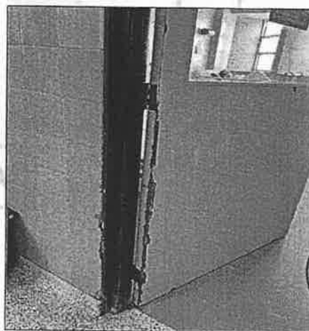
IMAGEN 04: MARCO Y PUERTA DETERIORADA POR EL TIEMPO
