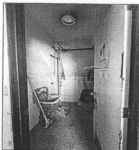
IMAGEN 02: LAVATORIO DETERIORADO, INSTALACIONES SANITARIAS SIN MANTENIMIENTO, PUERTA DETERIORADA
