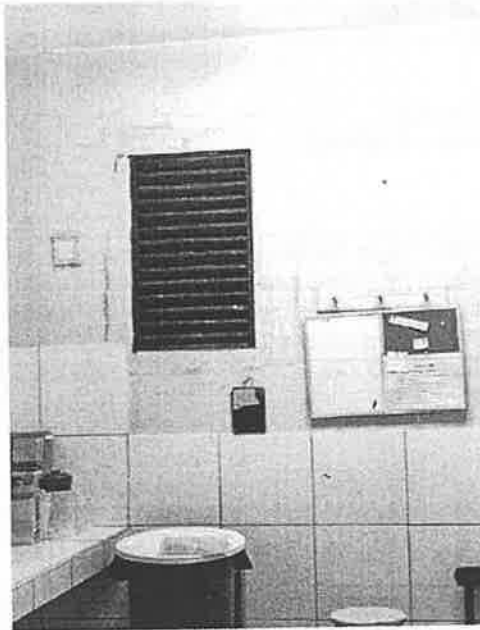
IMAGEN 29: VENTANA BATIENTE DAÑADA Y CON FALTA DE MANTENIMIENTO.
