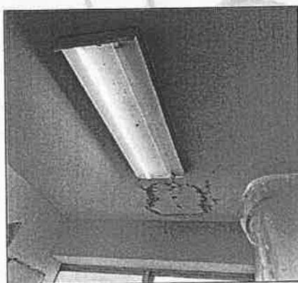
IMAGEN 09: TECHO CON PRESENCIA DE SALTRE Y LUMINARIA CON FUOROCENTE QUEMADO
