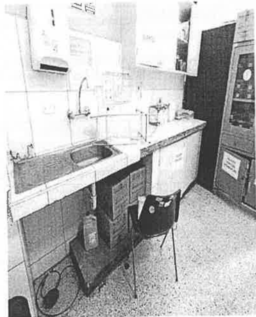
IMAGEN 30: DESPRENDIMIENTO DE CERAMICO, MUEBLE DE CONCRETO, LOCETAS ASTILLADAS Y MUEBLES ALTOS SIN CERROJOS
