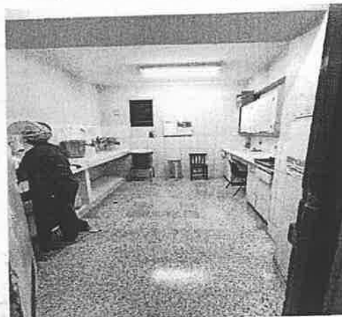
IMAGEN 20: AMBIENTE DE REPOSTERIA, SE VISUALIZA ZOCALO SIN COMPLETAR Y MUEBLES DETERIORADOS POR EL TIEMPO.
