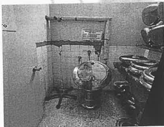
IMAGEN 21: PARED TARRAJEADA SIN PINTAR Y LAVACHATAS CON FALTA DE MANTENIMIENTO
