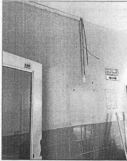
IMAGEN 11: CABLES EXPUESTOS
