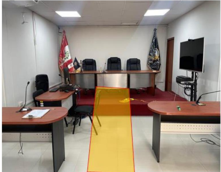
Fotografía: Imagen por donde pasara el tubo de desagüe y señalado la demolición del piso y desmontaje de altillo existente.
