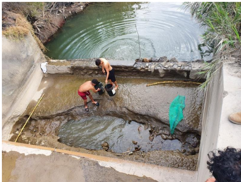
Canal Paiján: Poza de disipación en donde se ve los daños en la losa disipadora en la progresiva 0+093.
