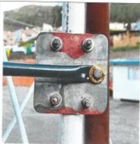
Foto 4 : vista del soporte del brazo del mástil de la antena anclado a la torre del proyecto CPACC
