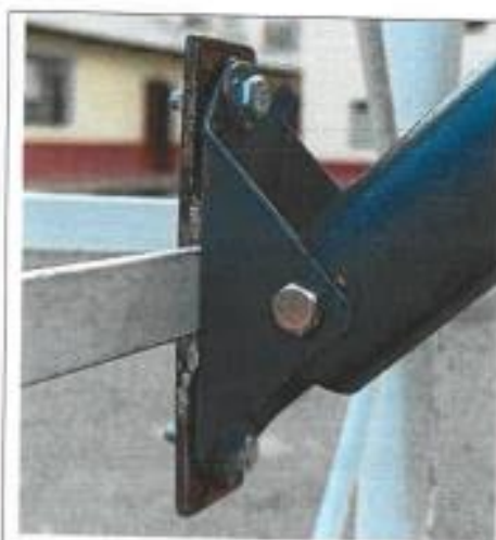
Foto 3 : vista de la base soporte del mástil de la antena anclado a la torre del proyecto CPACC
