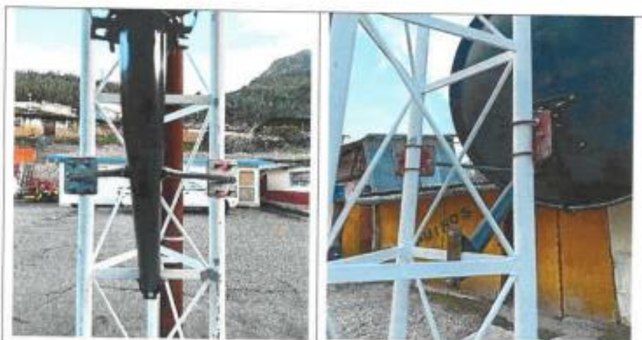
Foto 5 : vista frontal de los soporte de la base y brazos de la antena parabólica anclado a la torre del proyecto CPACC
