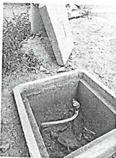
Puesta a tierra requiere mantenimiento
