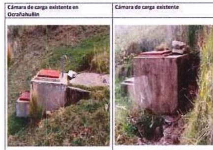
Cámaras de carga existentes en el sector de riego Ocráñahuñin.
