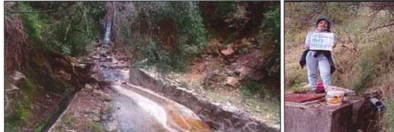
Fotografía de la bocatoma existente en la quebrada Sorapuquio Punqu y una captación de tipo ladera en el manante Sorapuquio del sector de riego Cconchayocc.
