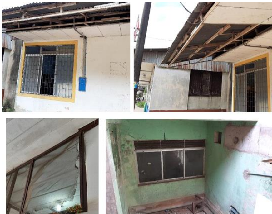
Foto 2, Mal estado de conservación de cielorraso y revestimiento.
