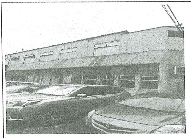
Foto 03: LAS FILTRACIONES OCURREN DEBIDO A LA FALTA DE AUN ADECUADO ALERO Y UNA FALTA DE CANALIZACIÓN DE AGUAS PLUVIALES
