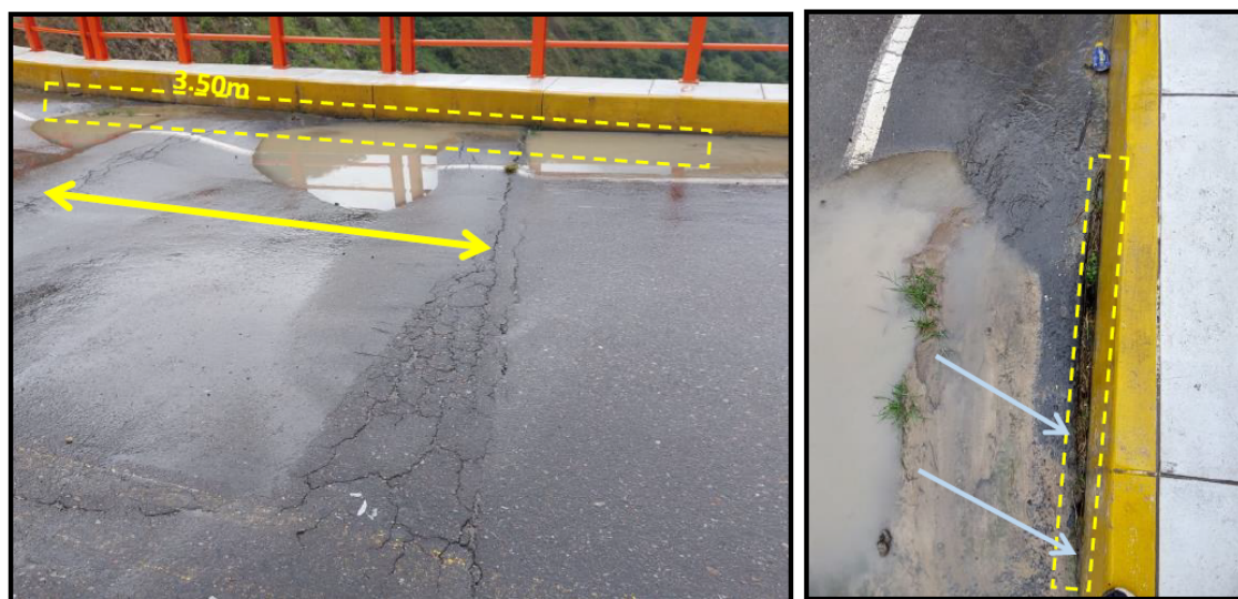
Figura 02. Corrugación con grietas
