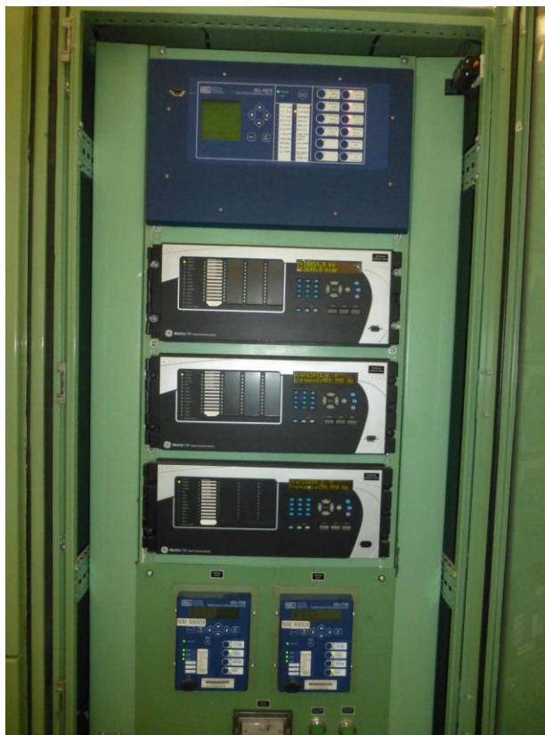
Figura 6 SET Majes Tablero de transformador T95-161
