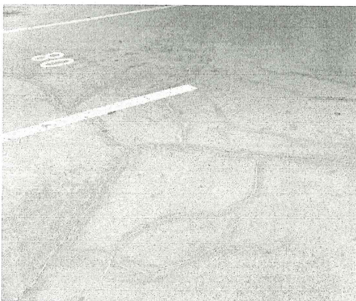
SE OBSERVA FISURAS Y GRIETAS ALEATORIAS EN LOSA DEL SÓTANO
