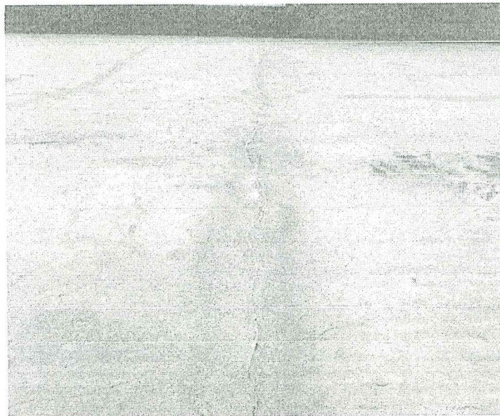
SE OBSERVA FISURAS Y GRIETAS LONGITUDINALES EN LOSA DEL SÓTANO
