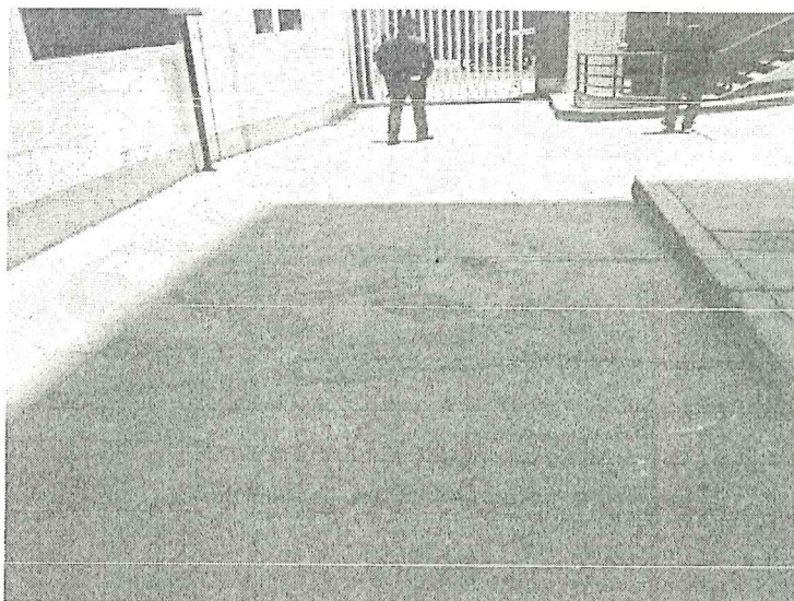
SE OBSERVA FISURAS Y GRIETAS TRANSVERSALES EN ZONA DE RAMPAS
