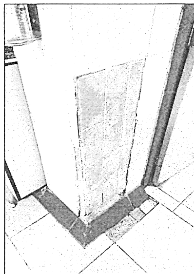
Imagen 6: Ambientes y pasadizos se encuentran con desprendimiento de pisos y muros.
