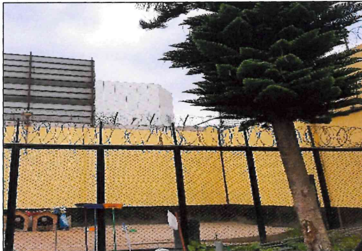
Concertinas deformes y en mal estado en tierra de nadie y en el muro de cerco perimétrico colindante con el exterior
