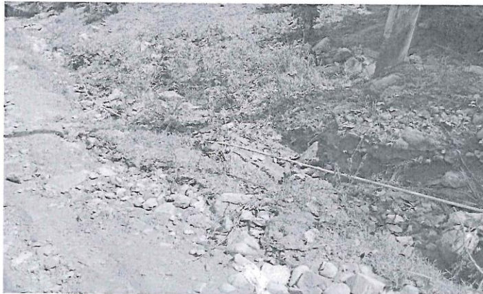
EN LA IMAGEN SE OBSERVA LA TUBERIA DE LA RED DE AGUA POTBALE EXPUESTA EN LA CUADRA 06 DEL JR. FEDERICO SÁNCHEZ.
