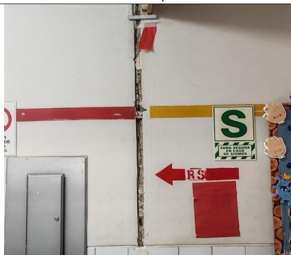
F17: Sellado de junta en muro I UPSS Emergencia
