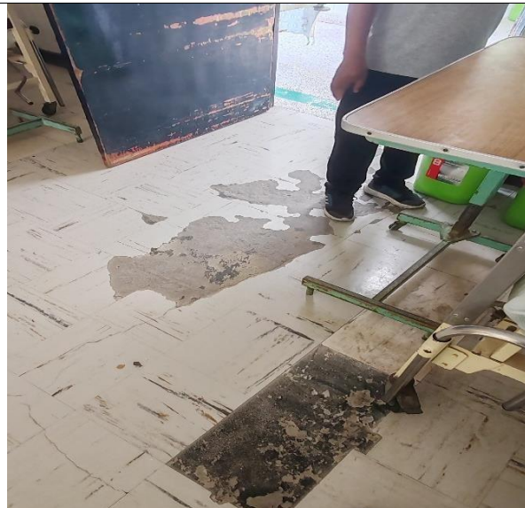
F10: Reposición de piso vinílico y manten. de puerta de madera
