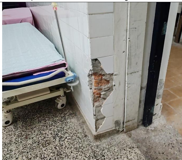
F22: Reposición de zocalos quebrados I Gineco Obst.
