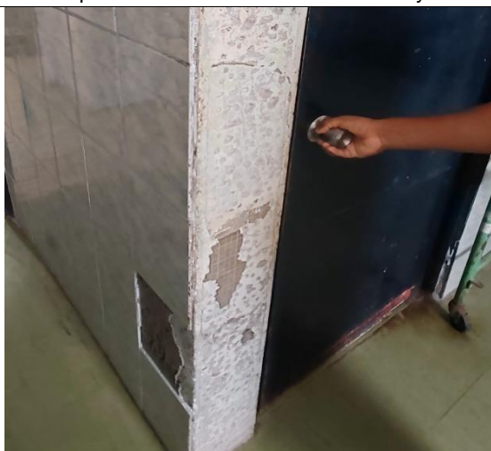
F16: Reposicion de zocalo quebrado I UPPSEmergencia
