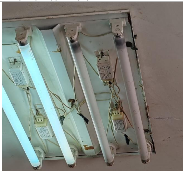
F20: Reposición de Luminarias malogradas I Corredor
