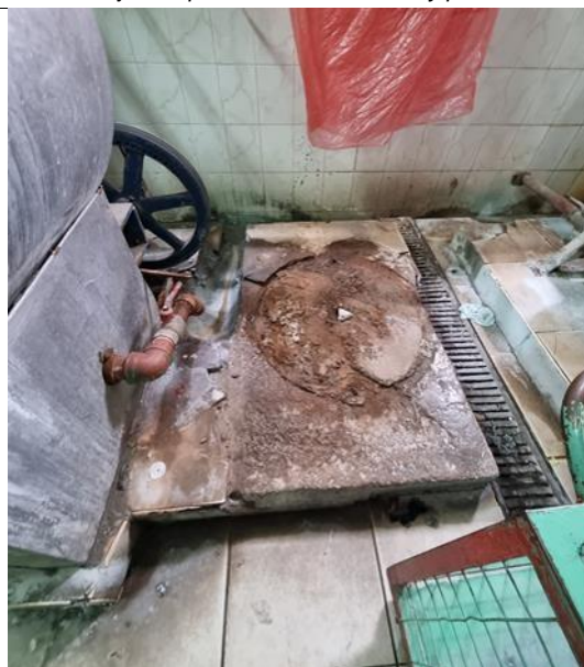
F6: Demolición de poyo en lavandería
