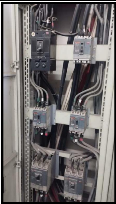
Fotografía N°4. En la imagen se muestra el estado de los interruptores de caja moldeada y los alimentadores de la celda FN
