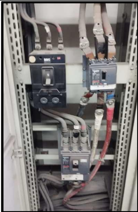
Imagen N°29. En la imagen se muestra el estado de los interruptores de caja moldeada y de los alimentadores del la celda AN
