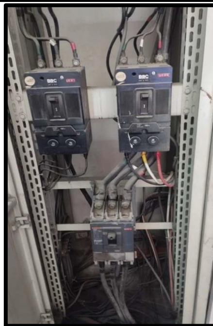
Imagen N°13. En la imagen se muestra el estado de los interruptores de caja moldeada y de los alimentadores de la celda AE
