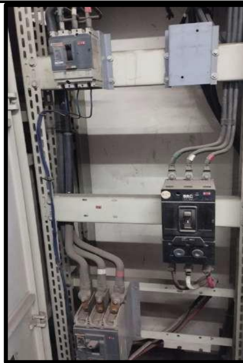
Fotografía N°2. En la imagen se muestran los interruptores de caja moldeada de la Celda – FN
