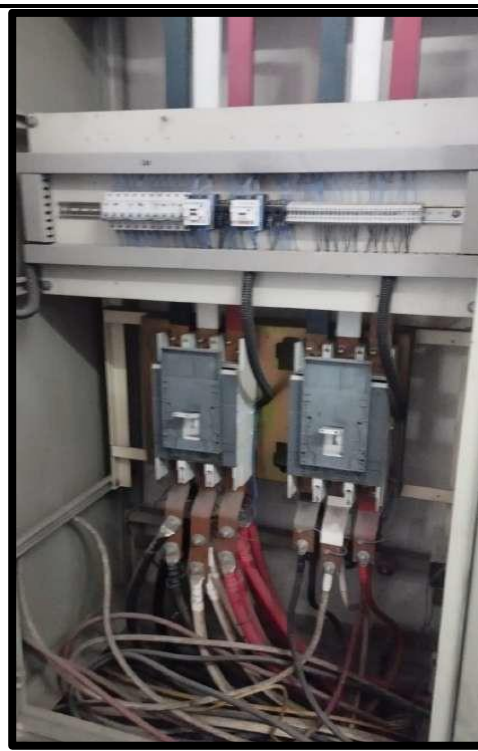
Fotografía N°7. En la imagen se muestra el estado de los interruptores de caja moldeada y de los alimentadores del Tablero de transferencia automática
