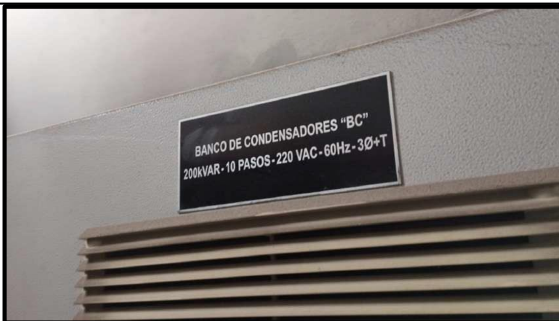
Imagen N°17. En la imagen se muestra las características del Banco de condensadores (10pasos)
