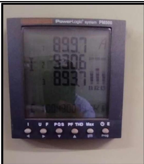
Imagen N°33 En la imagen se muestran los parámetros de corriente (Amp) y el consumo de energía de la celda AN - FN (kwh)
