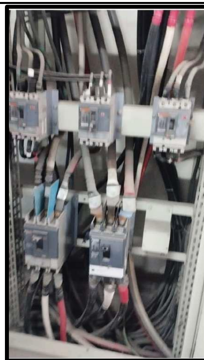
Imagen N°32 En la imagen se muestra el estado de los interruptores de caja moldeada y de los alimentadores del la celda AN - FN
