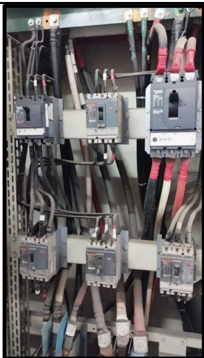
Imagen N°31 En la imagen se muestra el estado de los interruptores de caja moldeada y de los alimentadores del la celda AN - FN
