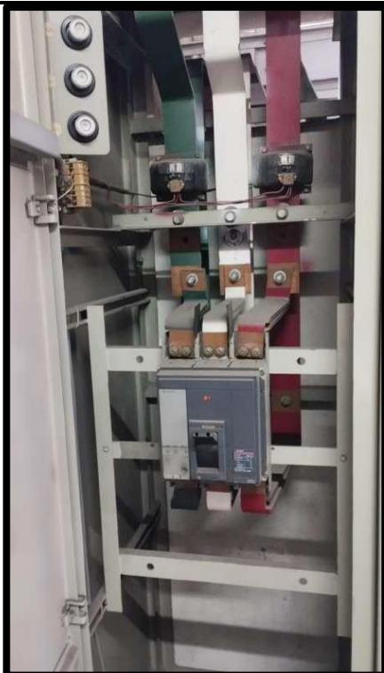
Imagen N°27 En la imagen se muestra el estado del interruptor de caja moldeada del tablero general de barras 2
