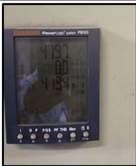
Fotografía N°26 En la imagen se muestran los parámetros de corriente (Amp) y el consumo de energía del tablero general normal de barras 1 (kwh)
