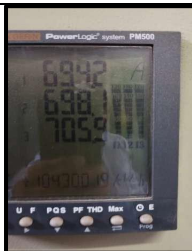
Fotografía N°24 En la imagen se muestran los parámetros de corriente (Amp) y el consumo de energía del tablero general normal de barras 2 (kwh)
