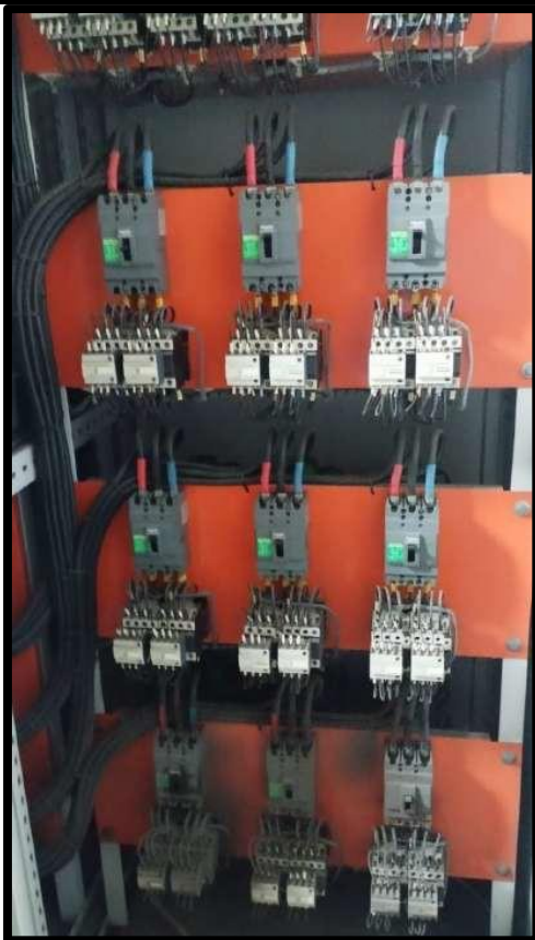
Fotografía N°19. En la imagen se muestra el estado de los interruptores de caja moldeada, los contactores y los alimentadores
