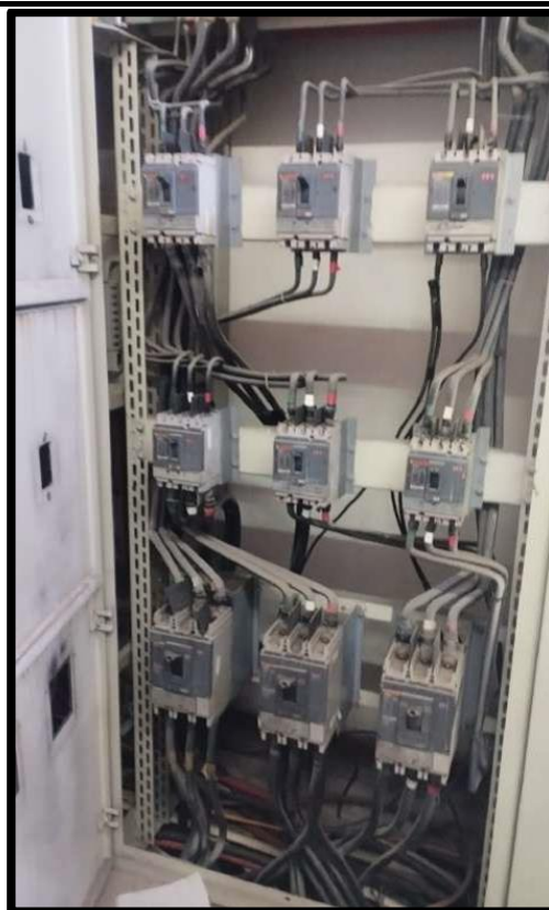
Fotografía N°9. En la imagen se muestra el estado de los interruptores de caja moldeada y de los alimentadores de la celda FE
