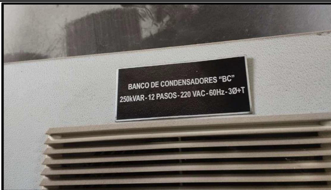
Imagen N°18. En la imagen se muestra las características del Banco de condensadores (12pasos)
