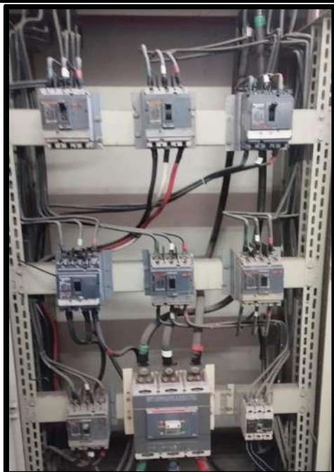
Imagen N°12. En la imagen se muestra el estado de los interruptores de caja moldeada y de los alimentadores de la celda AE
