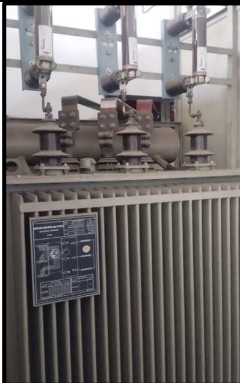
Imagen N°15. En la imagen se muestra el transformador principal de la subestación
