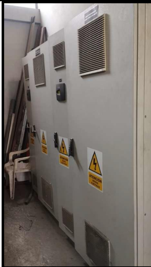
Fotografía N°20. En la imagen se muestran los gabinetes de los bancos de condensadores de 10 y 12 pasos
