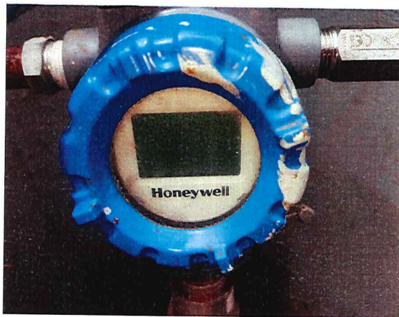
Foto N°22: Humedad en pantalla de transmisores Hart.
