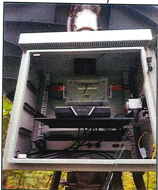
Foto N°3: Tablero de equipos de comunicación al nivel del suelo.
