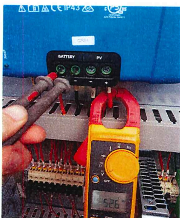
Foto N°26: Tensión de salida de regulador de
