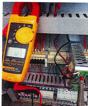
Foto N°25: Tensión de fuente de 12 Vdc: 12.1 Vdc
