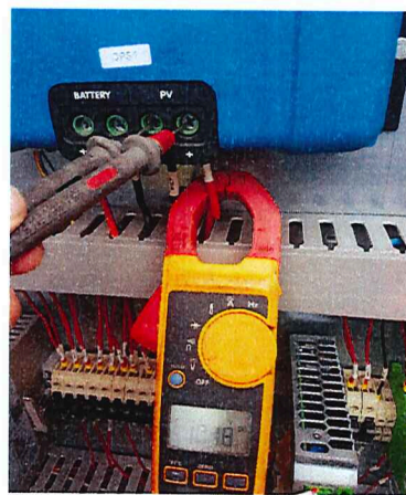
Foto N°27: Tensión de ingreso a regulador de carga-Paneles: 101.8 Vdc
