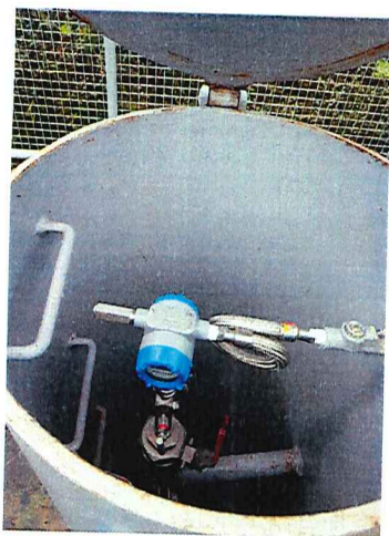
Foto N°3: Transmisor Hart 1 apagado.
