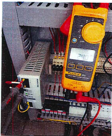
Foto N°24: Tensión de fuente 24 Vdc:
