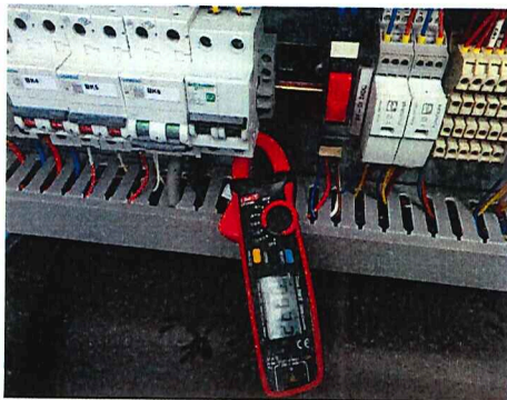
Foto N°5: Consumo ingreso del tablero de comunicaciones satelital INT7. 320 mAac
