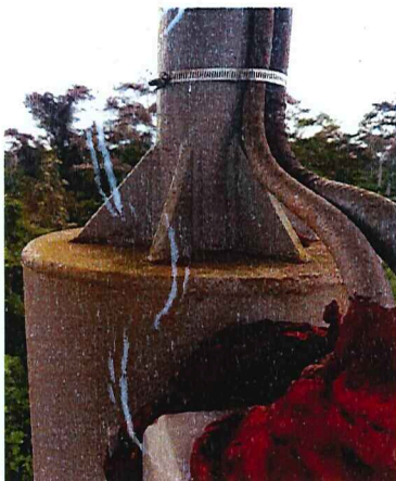
Foto N°32: Unión entre tubo de 16" y 4" soldadas.
