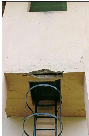
Imagen N° 8: Estructura de torreón con acero expuesto.
