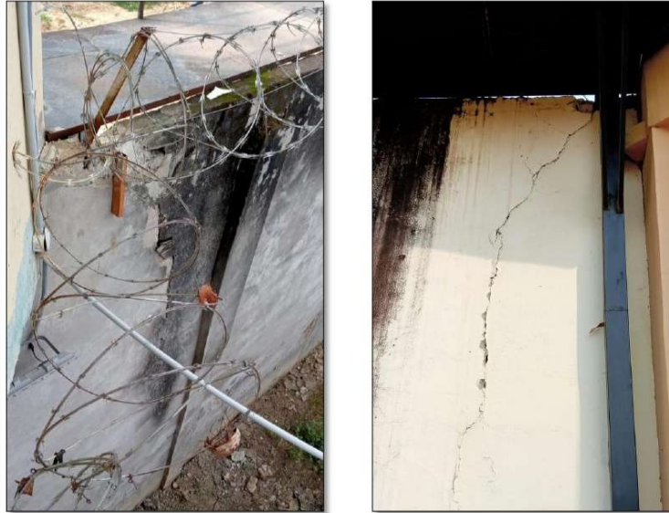
Imagen N° 7: Muro perimétrico con fisura grave, necesita urgente mejoramiento reforzado.
