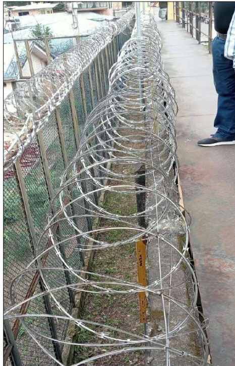
Imagen N° 14 Concertina que necesita ser reforzada.
