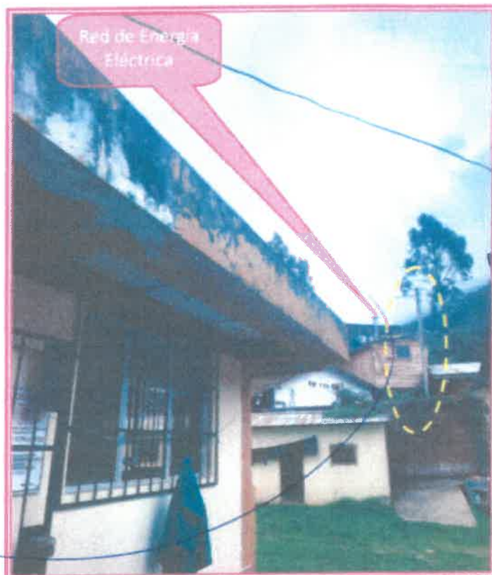
Foto N°10: La Red Energía Eléctrica de alimentación hacia el Puesto de Salud, instalada en la parte lateral derecho del EE.SS. Fuente: Elaboración Propia
