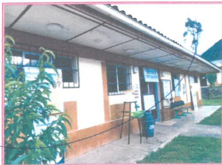
Foto N° 13: Fachada del Módulo A, acceso principal – Cielorraso con moho Fuente: Elaboración Propia
