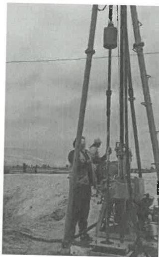
VISTA DE PERFORACIONES DE DIAMANTINA Y POZO DE EXPLORACIÓN.
