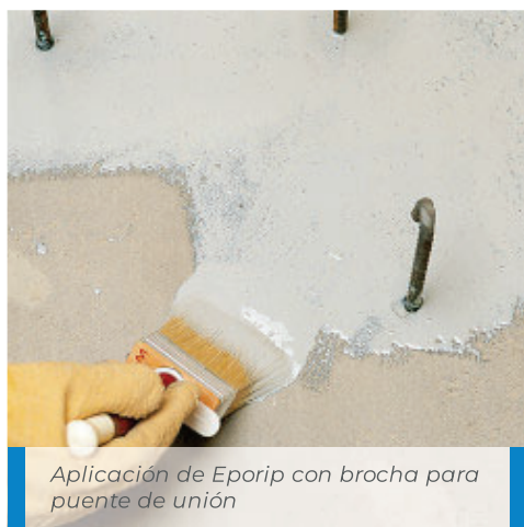
Reparación de grieta en recrecido cementoso con Eporip
