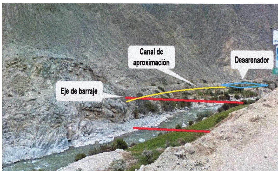
FIGURA N° 08. Esquema de captación (690msnm) vista desde aguas arriba
