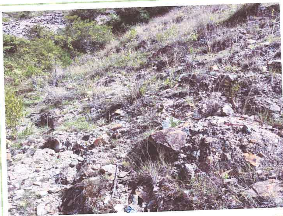
Imagen N° 7: Área de deslizamiento N°06 – pase de la red emisora de alcantarillado se visualiza áreas fragmentadas propensas a desprenderse
