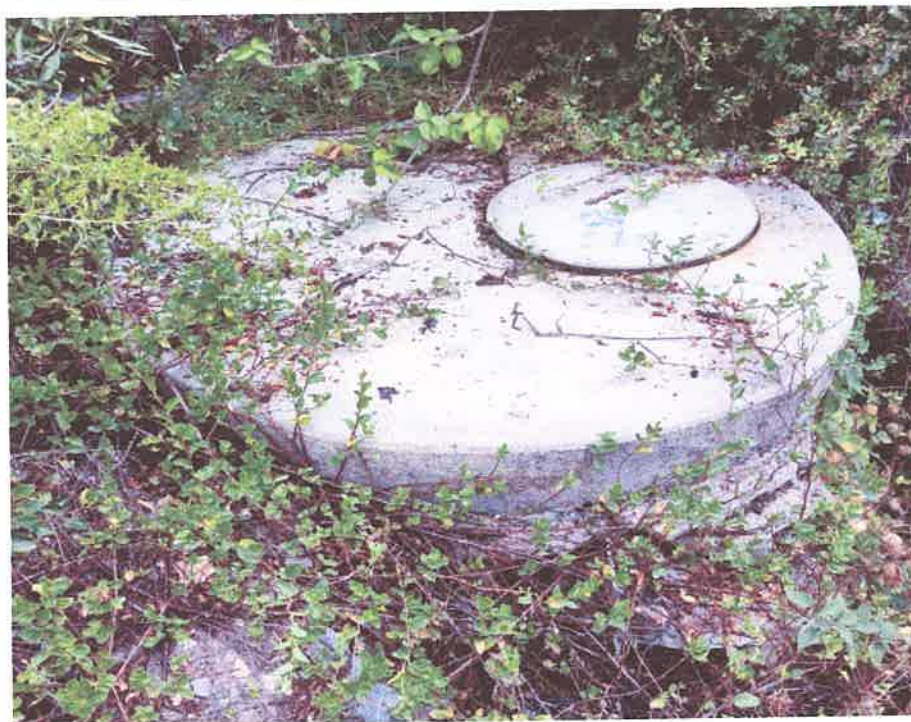
Imagen N° 23: Buzón con desprendimiento de concreto en sus muros
