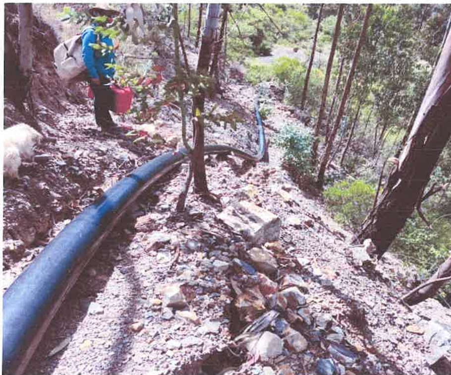
Imagen N° 19: Pase de la red emisora N°06 en suelos inestables
