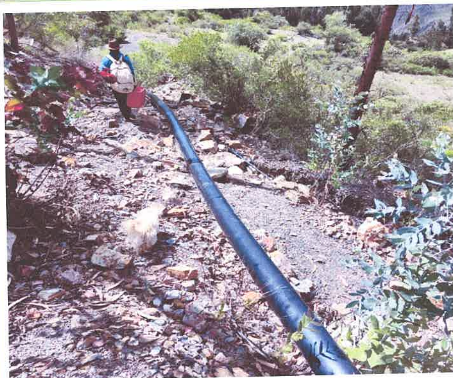
Imagen N° 13: Pase de la red emisora N°02 en suelos inestables
