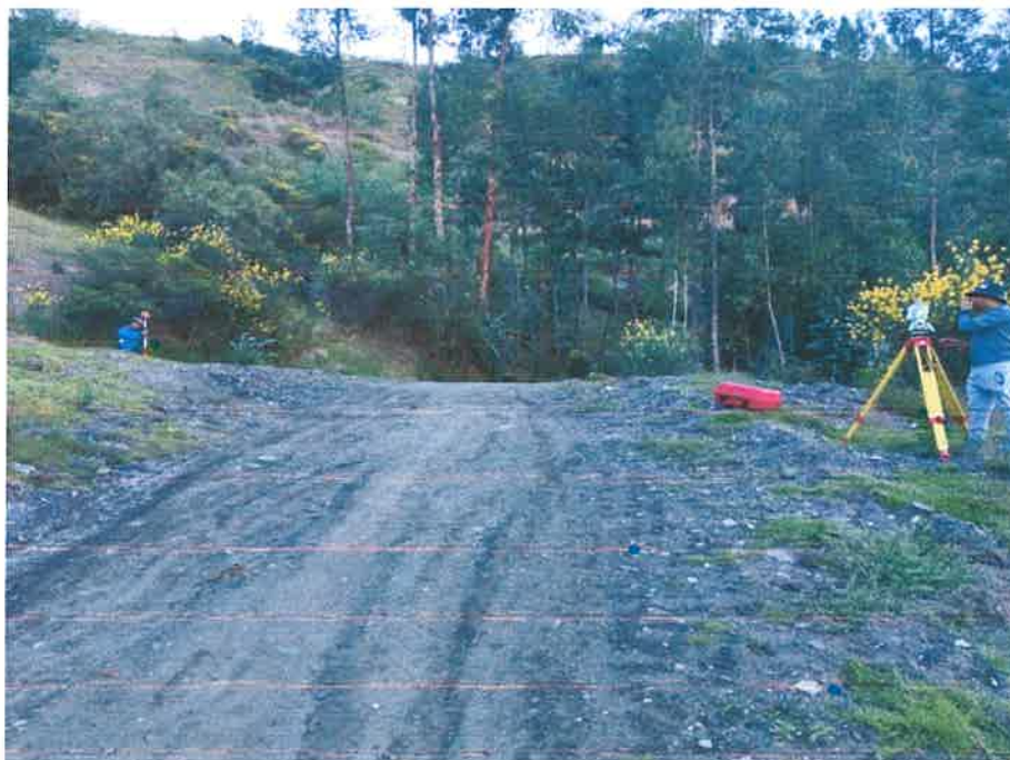
Imagen N° 27: Levantamiento topográfico del Pase de la red de alcantarillado.
