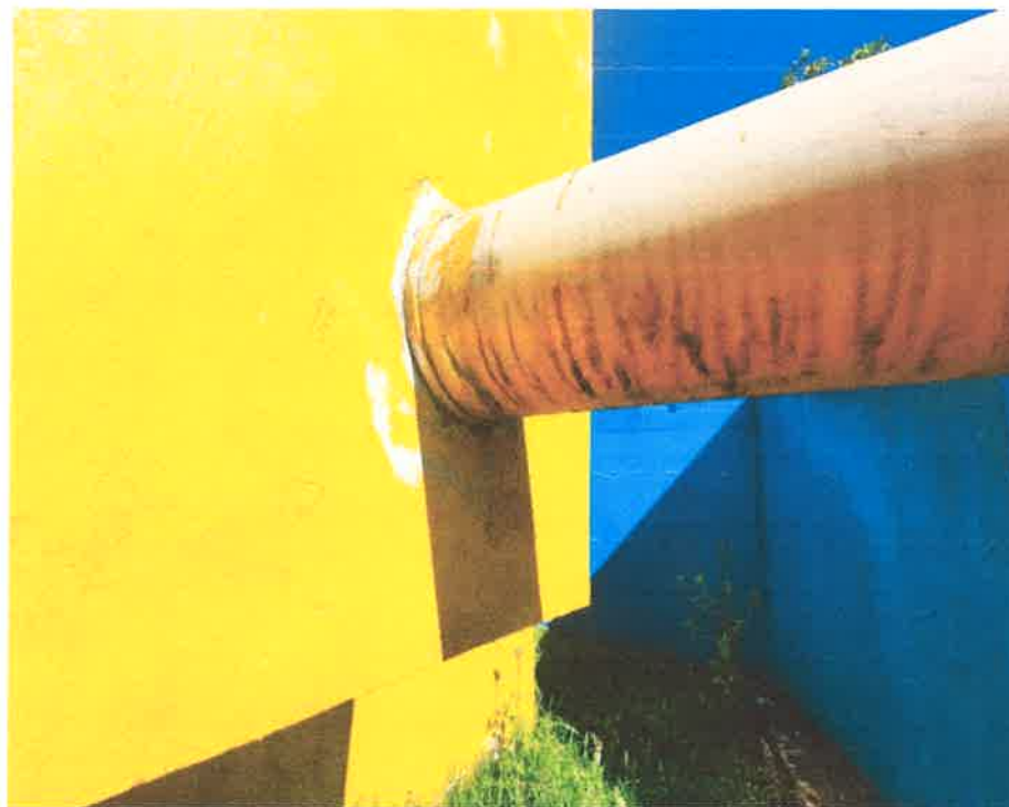
Imagen N° 34: Tubería de salida de lodos del tanque Imhoff hacia el lecho de secado.
