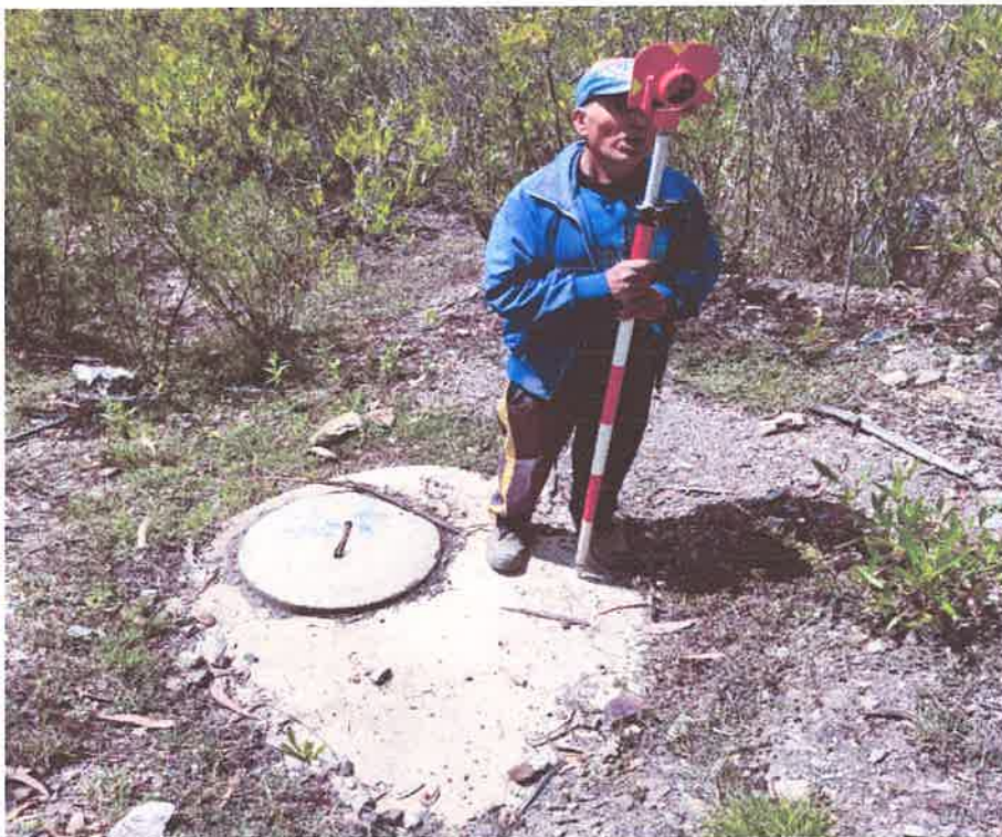
Imagen N° 20: Buzón cubierto casi enterrado por el terreno.
