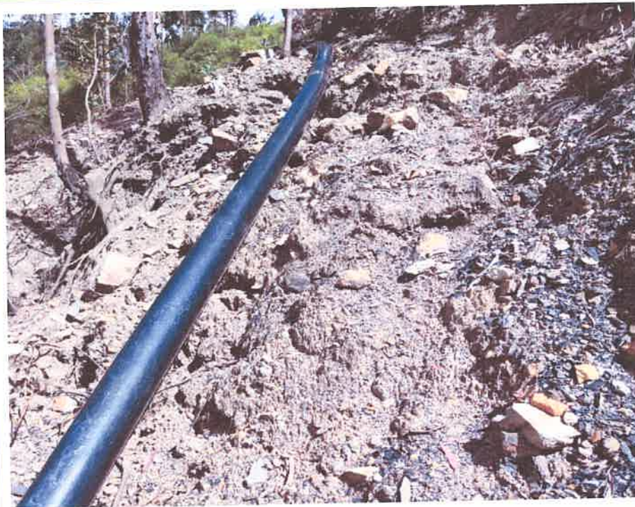
Imagen N° 14: Pase de la red emisora N°02 en suelos inestables
