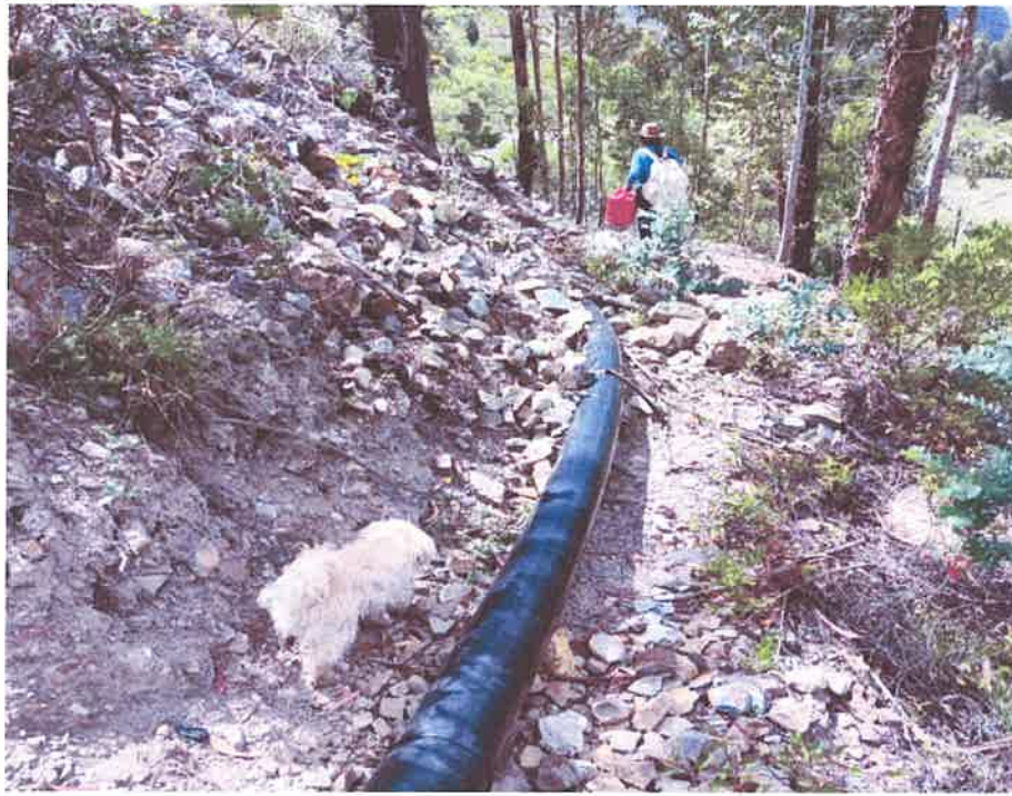
Imagen N° 18: Pase de la red emisora N°06 en suelos inestables
