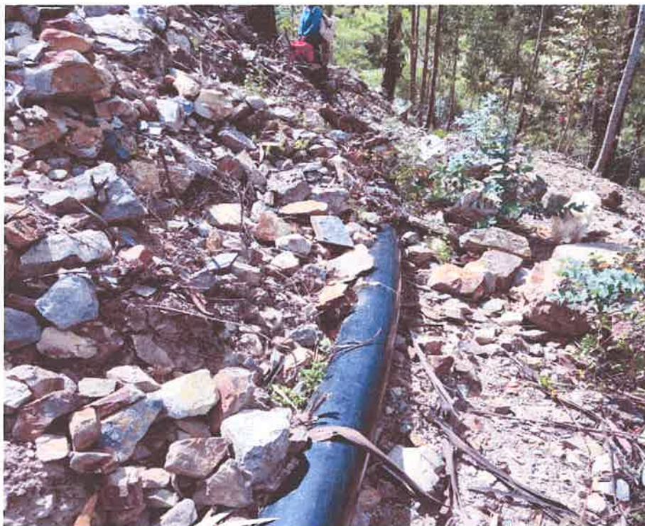
Imagen N° 17: Pase de la red emisora N°05 en suelos inestables
