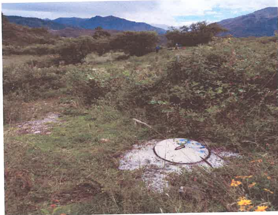
Imagen N° 21: Buzón cubierto por vegetación.
