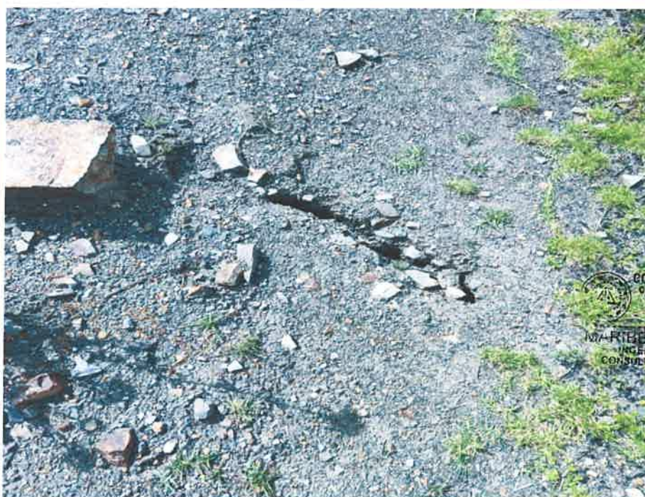
Imagen N° 11: Presencia de grietas de tensión debido a la reptación de los suelos a consecuencias a consecuencias de la presencia de aguas residuales.
