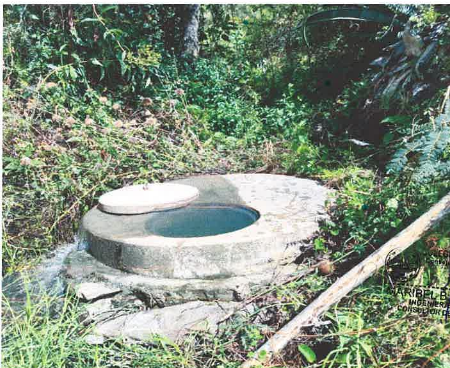
Imagen N° 28: Buzón colapsado, vertiendo el desagüe a los terrenos aledaños
