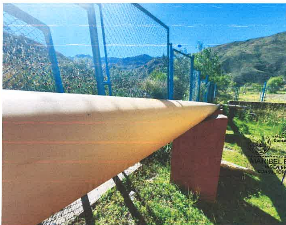
Imagen N° 35: Tubería que transporta el lodo hacia el lecho de secado.
