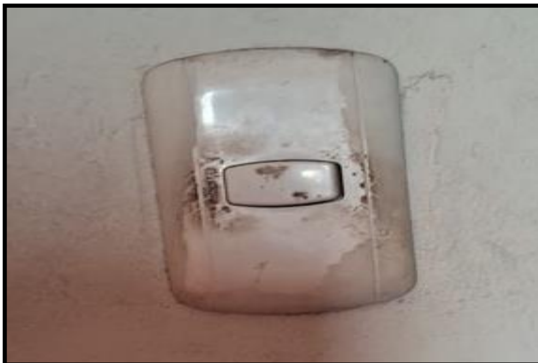
IMAGEN N° 99: en la imagen adjunta se evidencia el mal estado del interruptor simple.
