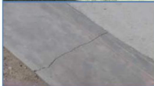
Fotos N° 41 y 42 :En vistas , se observa el aula pre fabricada donde funciona 1er y 2do grado primaria. Se observa además que la vereda en la parte frontal presenta fisuras
