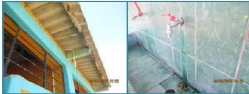
Foto N° 65-66: Se aprecia los SS.HH. para hombres y mujeres en mal estado de conservación. Material ladrillo, techo eternit. Rajado. Cuenta con pozo septico. Lavadero externo en malas condiciones.
