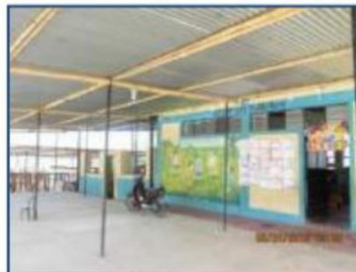
Foto N° 25: Se observa, el patio de formación piso de cemento, techo de calamina con correas de caña de Guayaquil.
