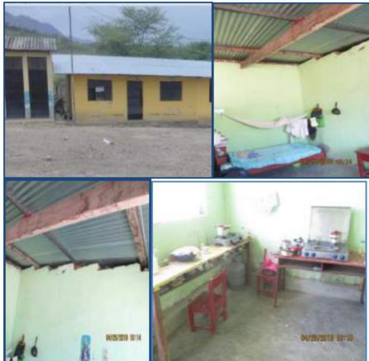
Fotos N° 56-59: En vistas se observa el frontis del ambiente donde se hospedan (02) docentes que lo utilizan para cocinar, dormir .Su interior se ve en mal estado. Presenta rajaduras en los muros. Partes de las paredes descubiertas donde entran arañas, zancudos.
