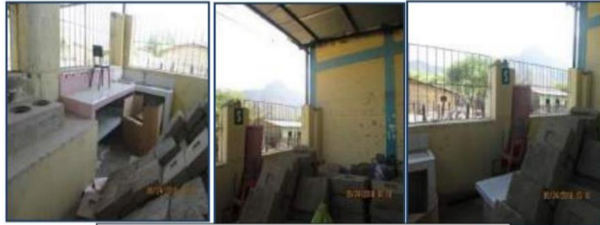
Fotos N° 12 al 14 : En vistas se observa éste ambiente para cocina-comedor construido por los mismos padres de familia, sin criterio técnico. Muros de adobe, techo calamina. Actualmente no lo utilizan porque van a levantar los muros con adobe. Mal estado.
