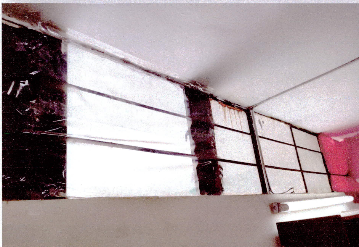
FOTO N°4: Se observa que la ventana está en mal estado de conservación, el cual genera un peligro para el área usuaria donde vienen laborando, se propone la instalación de nueva ventana, cambio de luminarias, reparación de techo, entre otros, el cual fueron solicitados por el área usuaria.
