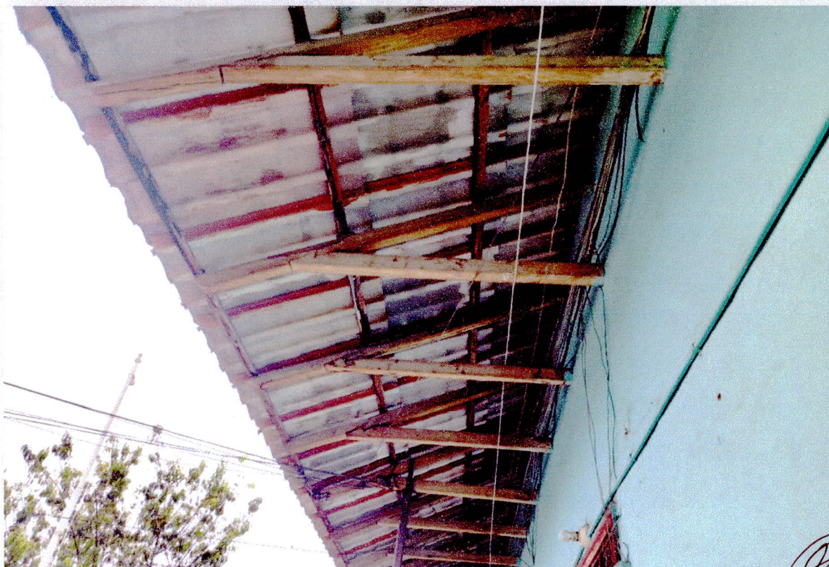
FOTO N°1: Se observa el estado actual de la circulación, barandas de madera tipo balaustres, estructura de madera, piso en mal estado de conservación, entre otros, falta de mantenimiento y reparación, falta de luminarias, otros, el cual ha sido solicitados por el área usuaria.
