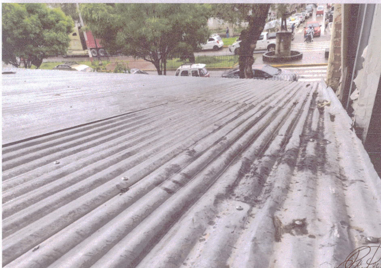
FOTO N°2: Se observa que la cobertura (calaminas) existen goteras, se propone cambio de calaminas, reparaciones, entre otros, el cual fueron solicitados por el área usuaria.
